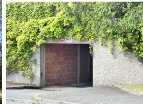
Parking souterrain ouvert
