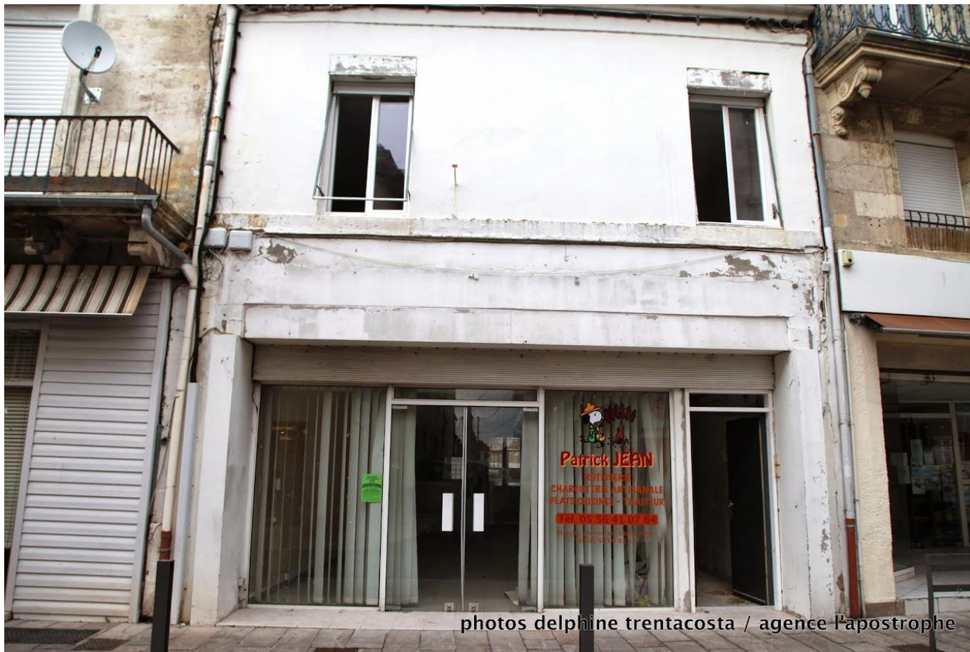
Photo du local sis 19 rue Jean Jacques Rousseau avant travaux Crédit photo Delphine Trentacosta
