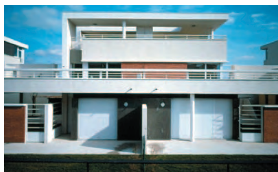
opération d'Elancourt, architecte Pascal Quéré
