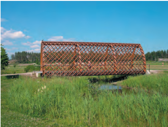
Quartier de Viikki, Helsinki (Finlande) - Collecte, utilisation, réduction de l'imperméabilisation
