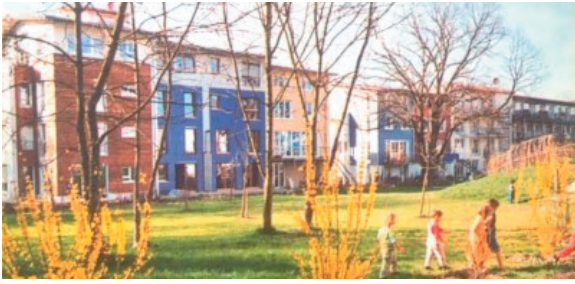
Quartier Vauban, Fribourg (Allemagne) – Réduction de l'imperméabilisation
