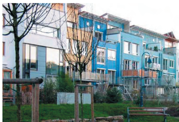
Quartier Vauban, Fribourg (Allemagne) - Parking relais
