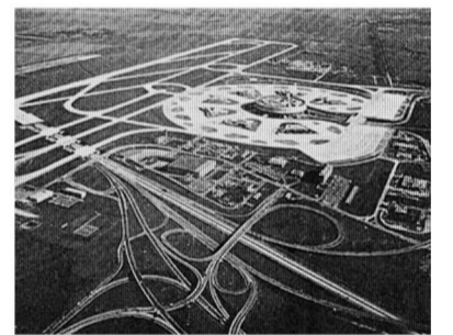
Chantier de l'aéroport Roissy Charles de Gaulle
