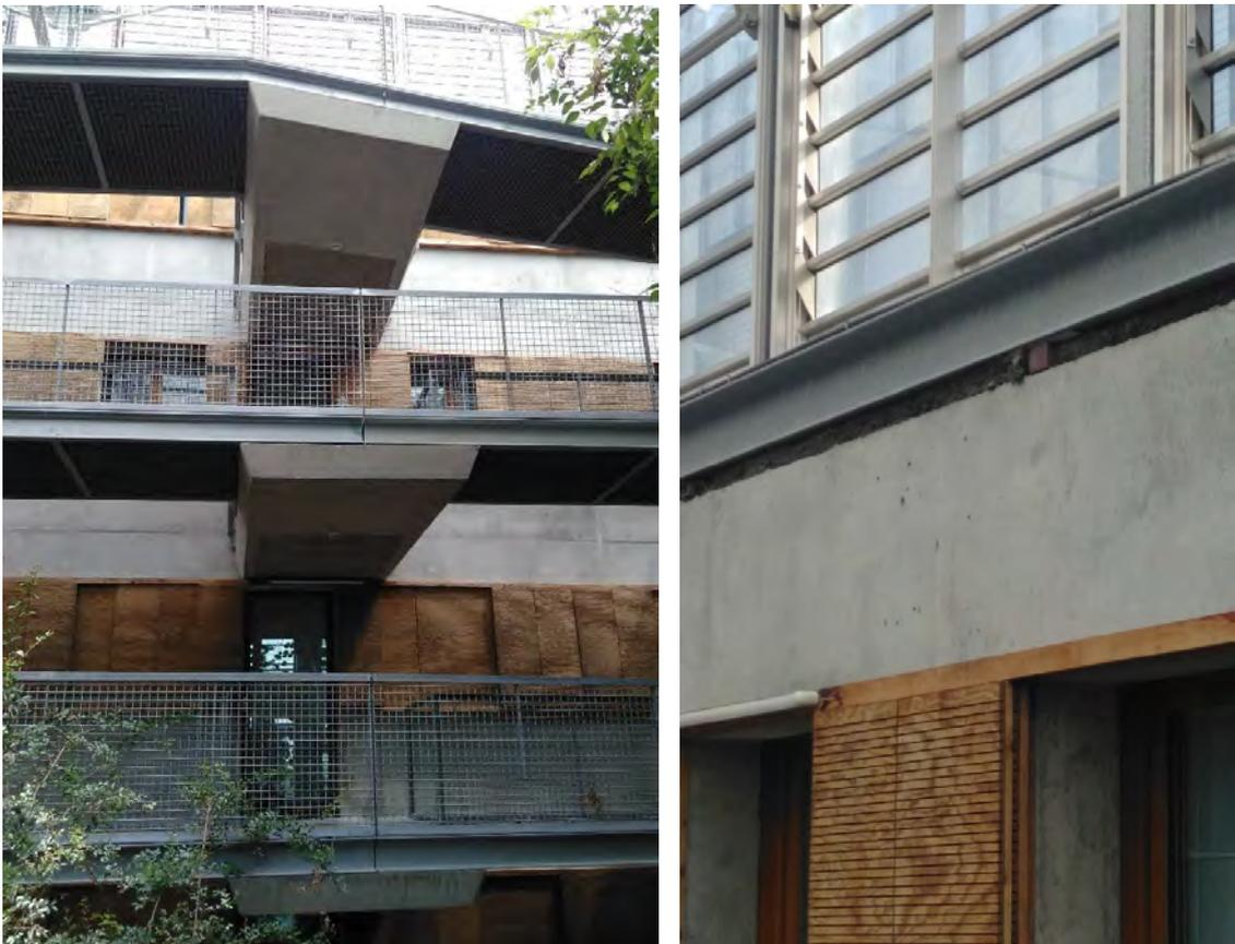
9. et 10. *Structure des paliers en béton et système anti-vibratile pour désolidariser la toiture de la serre du corps principal du bâtiment.*
