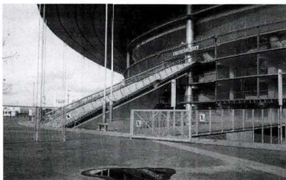
Portails commandés à distance entre les secteurs des tribunes du Stade de France.
