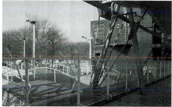
Clôtures interrompues par une « Folie » du parc de la Villette accueillant les contrôles d'accès du jardin des Dunes.
