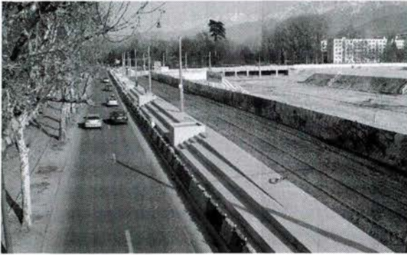
Site propre de la ligne C du tramway, longeant le futur stade de Grenoble.
