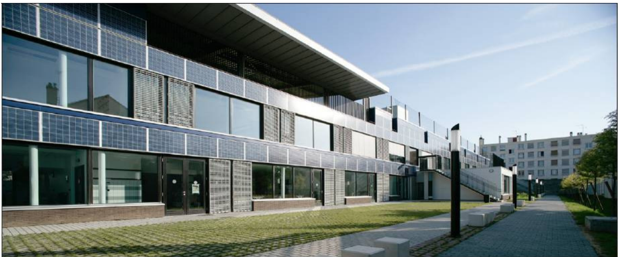
FIGURE 4 : VUE D'INTEGRATION DES PANNEAUX PHOTOVOLTAIQUES EN FACADE DEPUIS L'AIRES D'ARRIVEE DES PRIMAIRES
