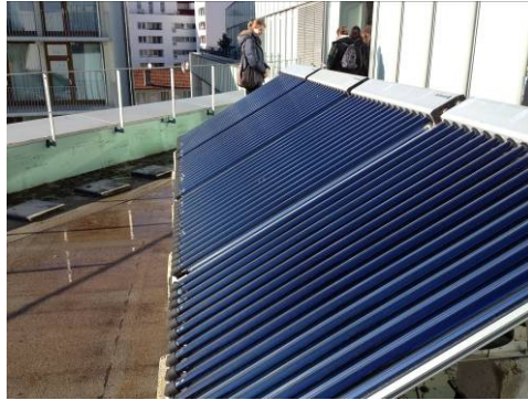
FIGURE 40 : CAPTEURS SOLAIRES THERMIQUES EN TOITURE
