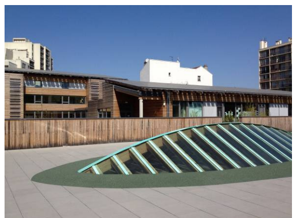
FIGURE 22 : COUR DE RECREATION DES MATERNELLES IMPLANTEE SUR LA TOITURE
