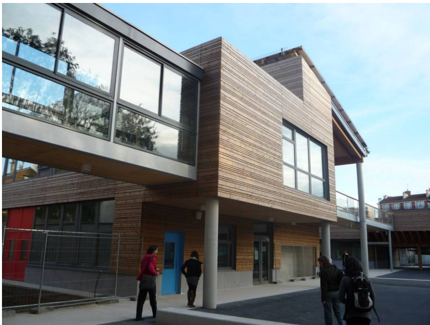
FIGURE 27 : PASSERELLE ENTRE LES BATIMENT A ET B
