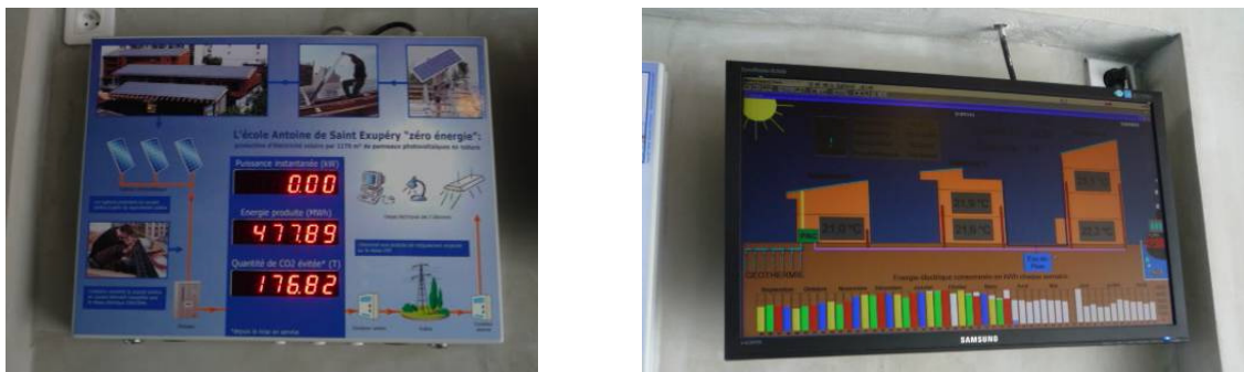
FIGURE 33 : ECRANS D'AFFICHAGE DES CONSOMMATIONS ENERGETIQUES EN TEMPS REEL DANS LE HALL D'ACCUEIL DU BATIMENT A
