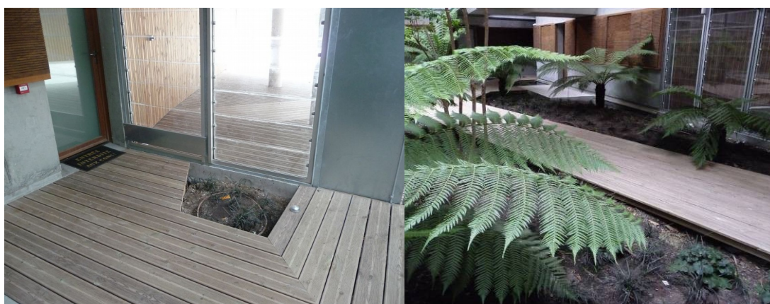
Illustration 15: circulations intérieures en platelage bois, risque de chute pour un fauteuil ?
