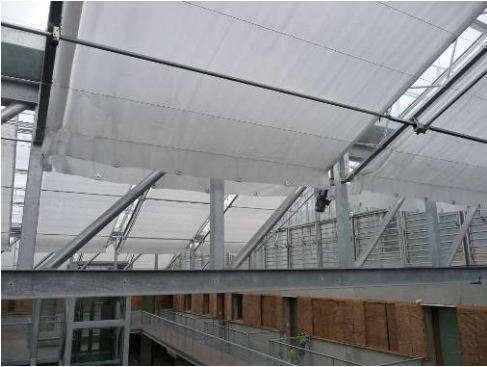
Store automatisé de la serre : affaiblissement important de la luminosité intérieure
