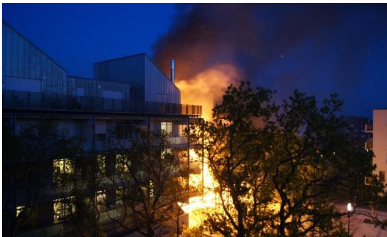
Illustration 14: photographie de l'incendie le 19/04/2015 à 22h source SDIS 35
