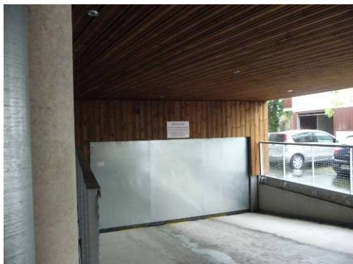
Rampe d'accès au parking souterrain
