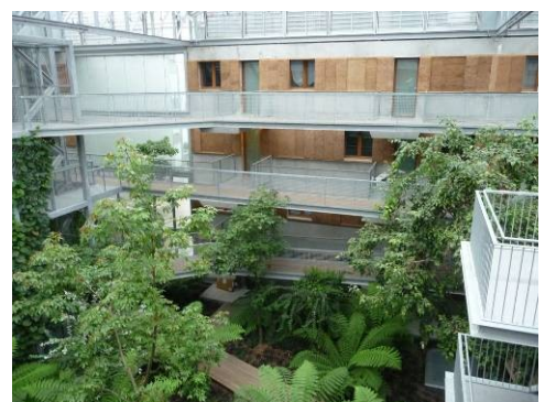
Vue intérieure de la serre bioclimatique : une sobriété déconcertante pour un bâtiment de logement
