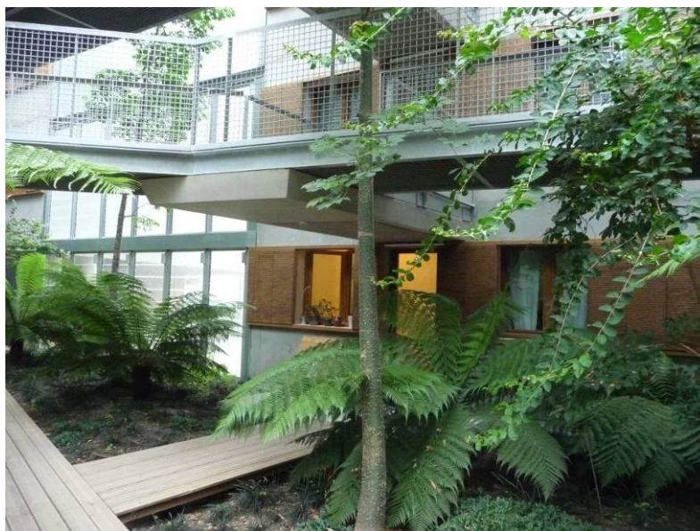
Illustration 16: vue sur l'intérieur des logements depuis la serre
