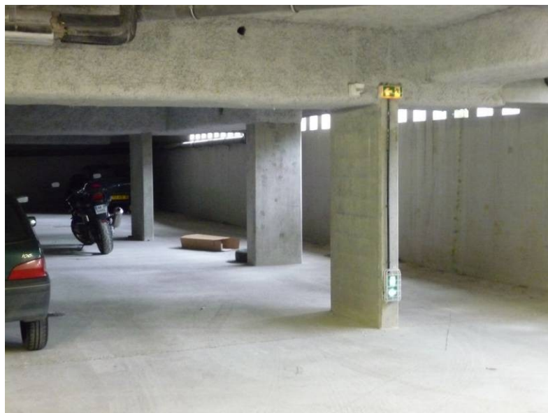
Illustration 9: stationnement au sous-sol, absence de marquage au sol, déchets au sol
