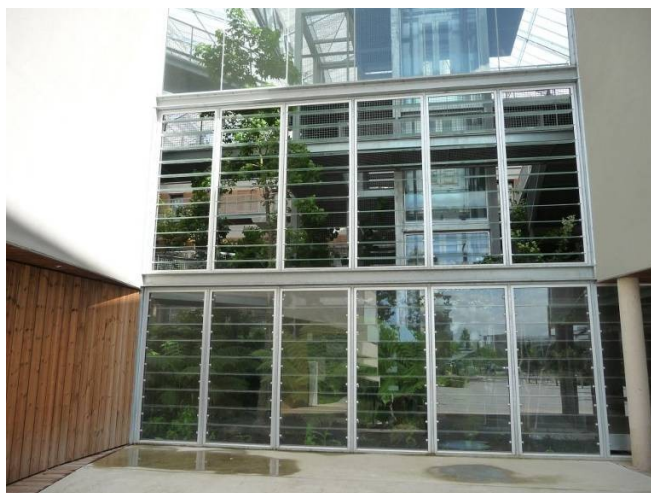
Illustration 21: mur rideau sur la façade ouest du bâtiment. Ventelles en position ouverte au niveau 1
