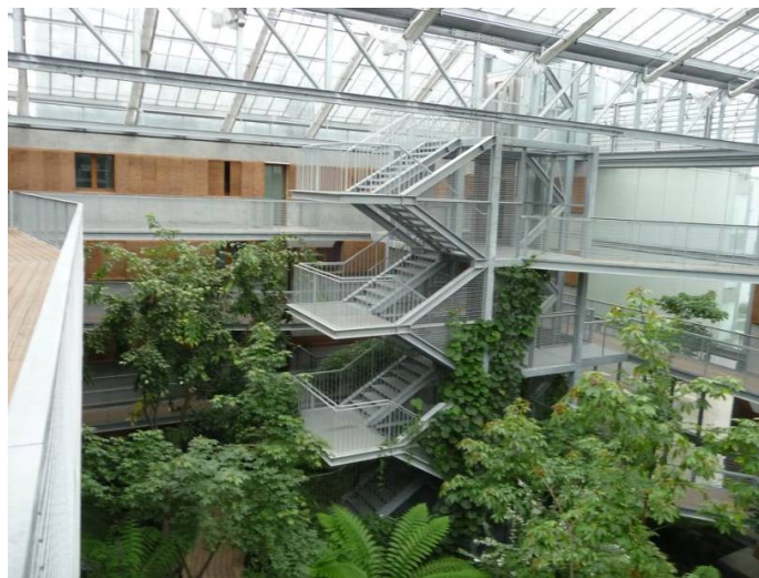
Illustration 35: structure métallique et végétation dans la serre
