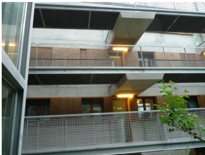
Illustration 20: éclairage artificiel au-dessus des portes palières allumé en pleine journée...
