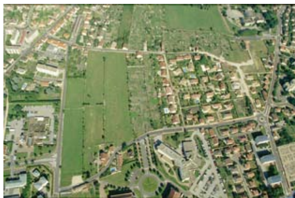
Vue aérienne du site avant travaux
