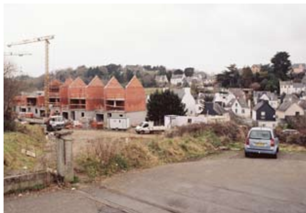
Chantier de VUD Quimper
