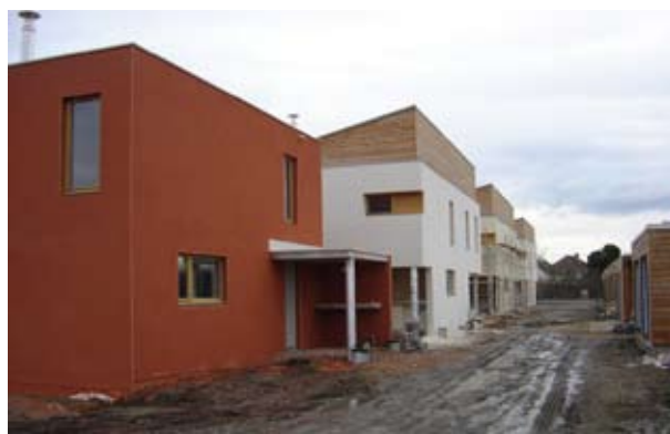
Chantier en cours d'achèvement
