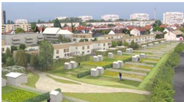
Vue aérienne du projet VUD Chalons
