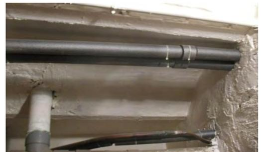
Figure 5 - tuyaux de chauffage au plafond des caves
