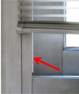
**Figure 7 - mauvaise étanchéité à l'air des menuiseries**
