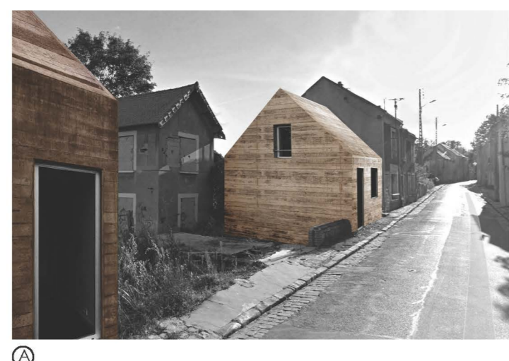
① Pour conserver la structure urbaine historique, les constructions détruites sont reconstruites selon le même gabarit dans de nouveaux matériaux: béton brut...
