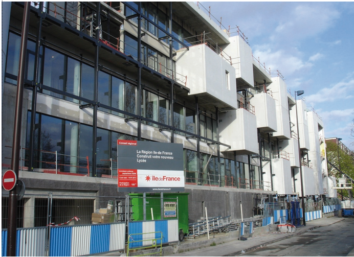
Vue sur le lycée Schuman pendant la construction / Photo : Epicuria architecture
