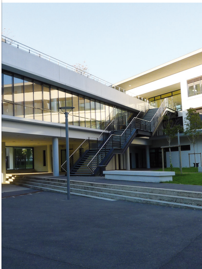
L'escalier interdit d'accès aux élèves dans la cour / Photo URCAUE-IdF
