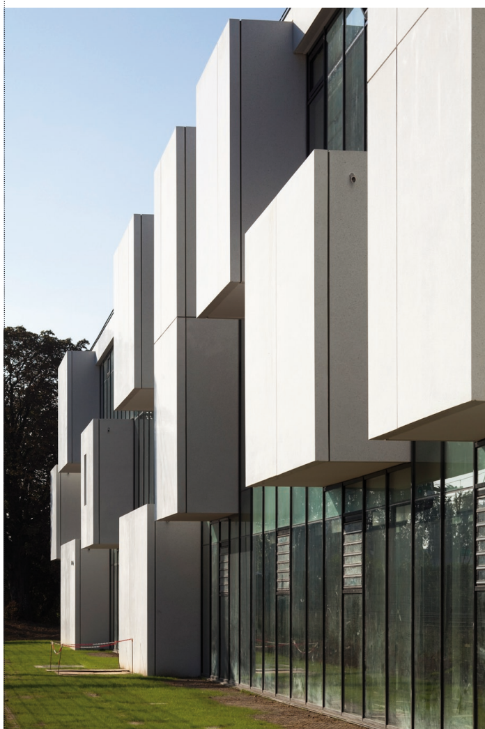
Les locaux techniques en saillie sur les façades extérieures / Photo : Nicolas Borel
