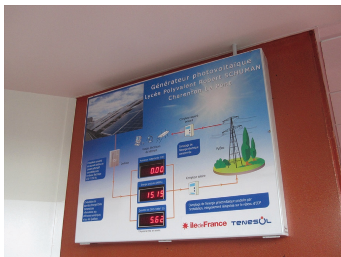
Panneau d'affichage de la production photovoltaïque / Photo URCAUE
