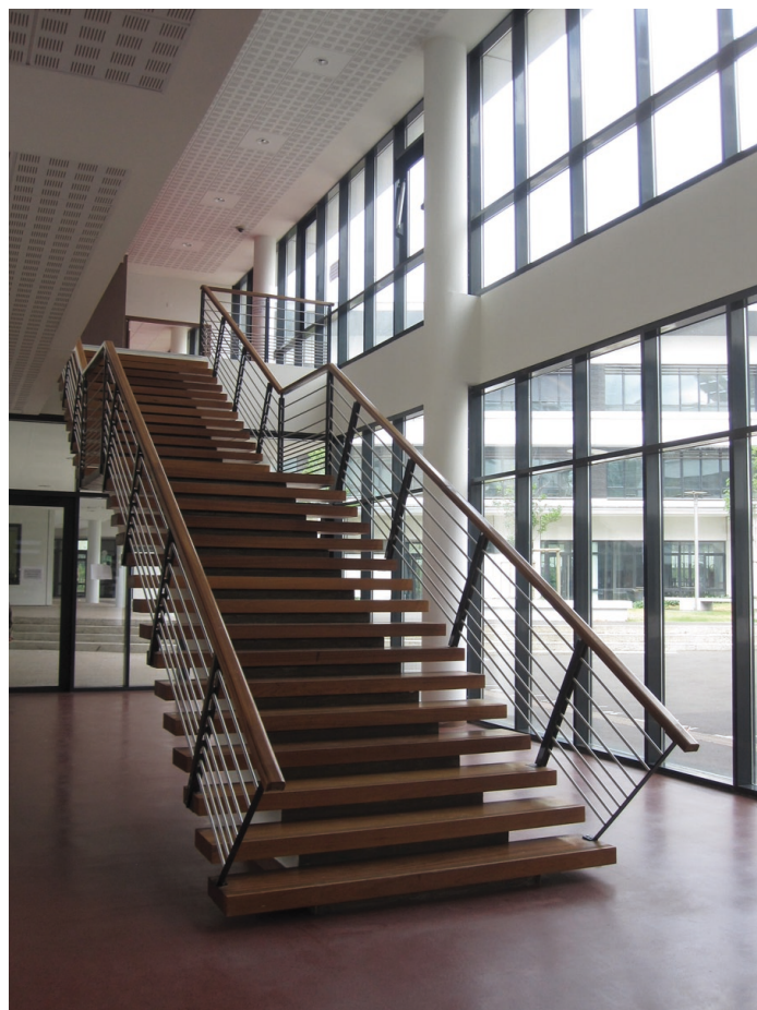
L'escalier interdit d'accès aux élèves dans le hall du lycée / Photo URCAUE-IdF
