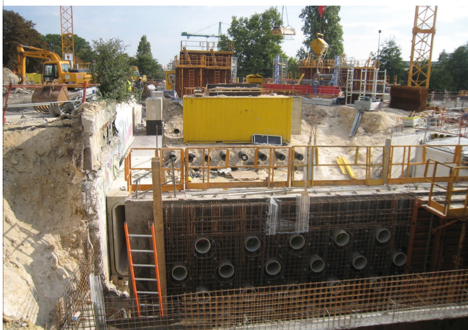
Construction du puits canadien / Photo : Epicuria architecture
