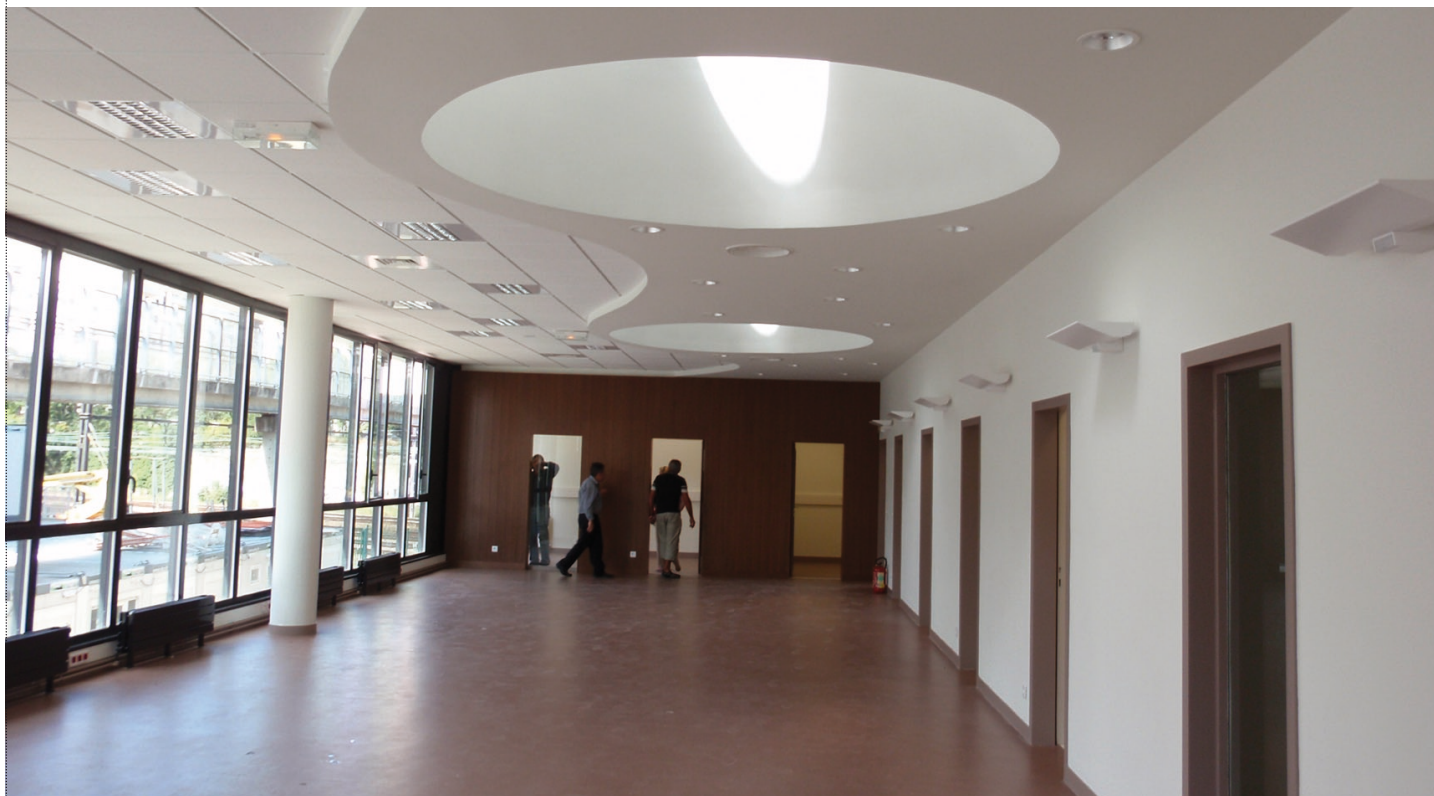
Le CDI bénéficie d'un éclairage zénithal grâce aux puits de lumière installés dans le jardin en toiture / Photo Epicuria architectes
