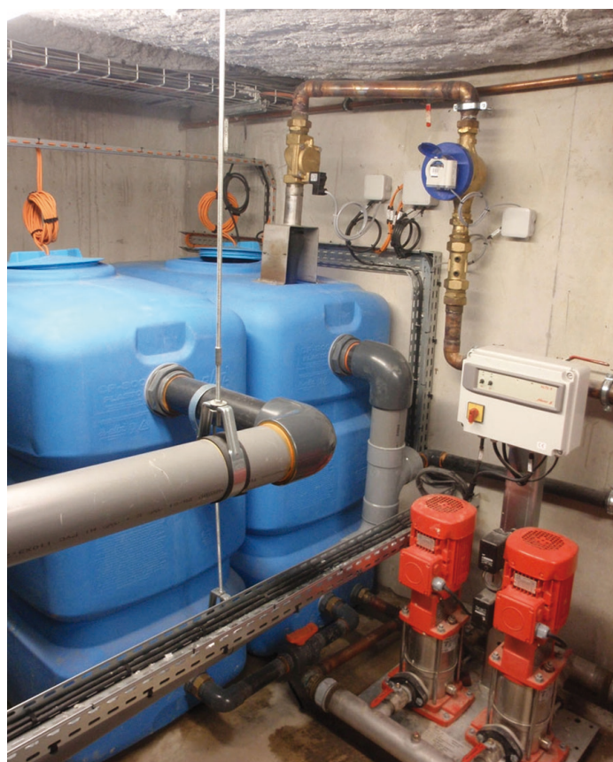
Cuves de récupération des eaux de ruissellement de toiture / Photo : Epicuria architecture
