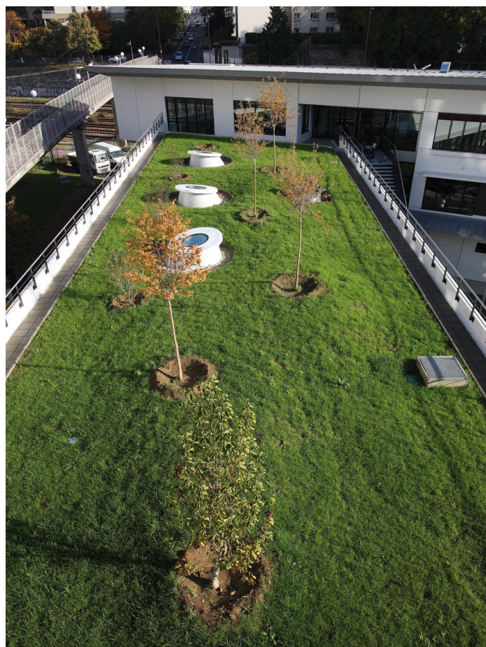
Le jardin en toiture ; en arrière-plan, l'entrée de la salle d'arts plastiques et la partie haute de l'escalier donnant sur la cour / Photo Nicolas Borel
