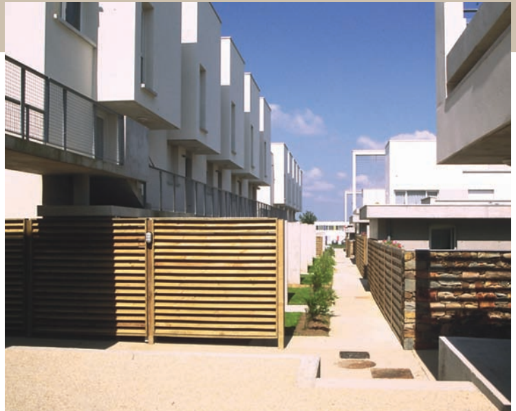
Opération European 3 Plérin-sur-Mer Maîtres d'ouvrages: Armorique Habitat et Ville de Plérin-sur-Mer Architecte : CITArchitecture
