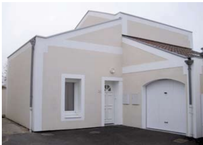
Migné-Auxances : un bâtiment réhabilité.
