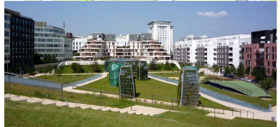
2. Centre commercial de la Vache Noire à Arcueil : parc sur le toit, logements autour de l'opération.
