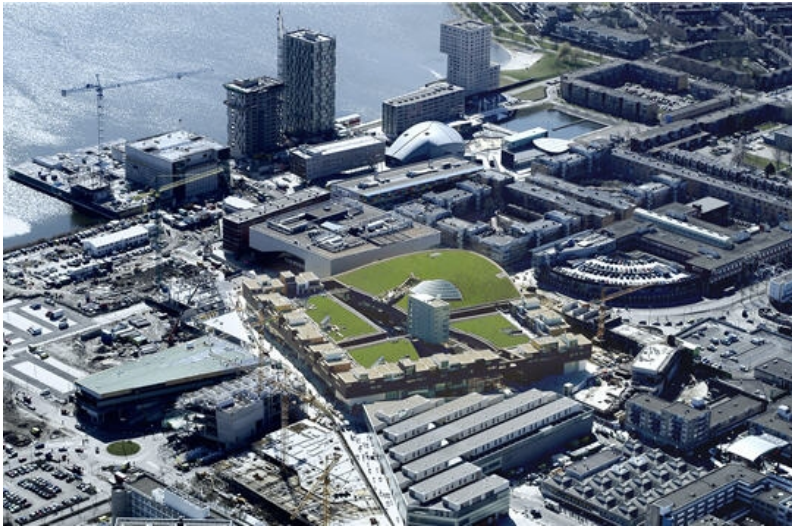
1. Centre commercial à Alemer (Hollande), Portzamparc : RDC galerie commerciale, logements en étage.
