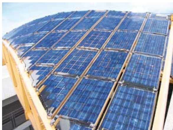
Panneaux photovoltaïques d'essais Université de Saint-Pierre à la Réunion - Photo MEEDDAT
