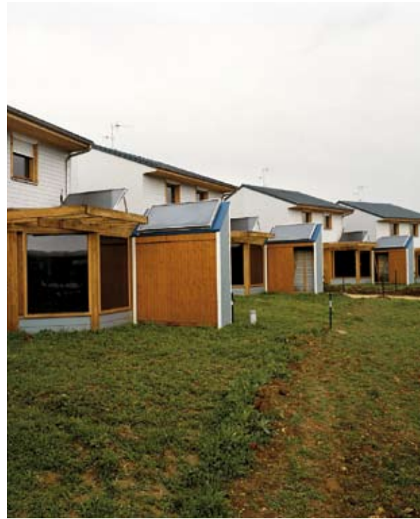
Intégration des panneaux solaires pour le préchauffage de l'eau chaude sanitaire Opération Villa Urbaine Durable de Bourges - Photo Éric Bernath
