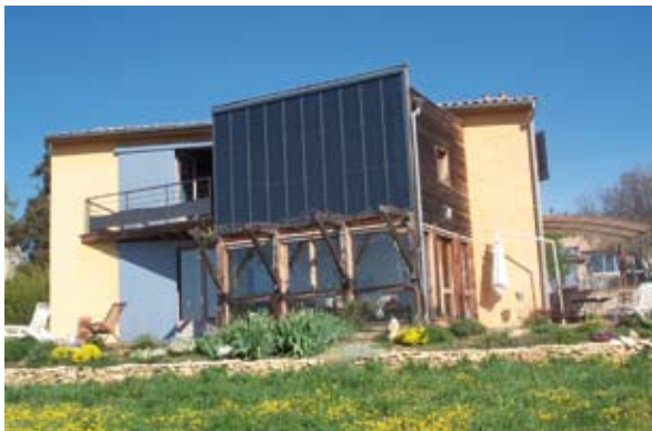
Orientation sud, serre bioclimatique et intégration de panneaux solaires, un exemple d'architecture bioclimatique passive de maison individuelle Maison DETOT KAVOUDJIAN - Photo CETE Méditerranée
