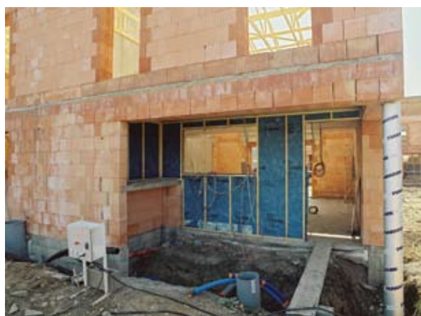
Du Monomur pour optimiser la performance thermique Opération Villa Urbaine Durable de Châlon-sur-Saône - Photo Éric Bernath
