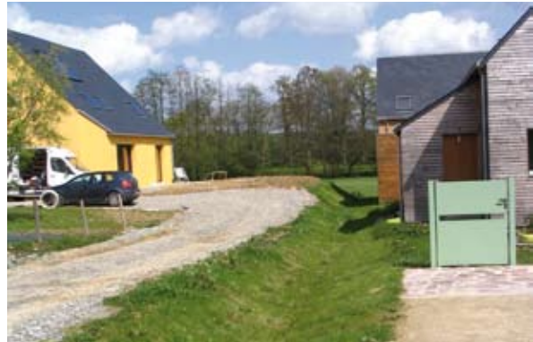
Sol stabilisé sur espace public non bitumé à Langouët (35) Photo MEEDDAT
