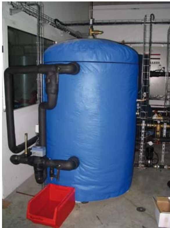
Chauffe-eau solaire Université de Saint-Pierre à la Réunion - Photo MEEDDAT
