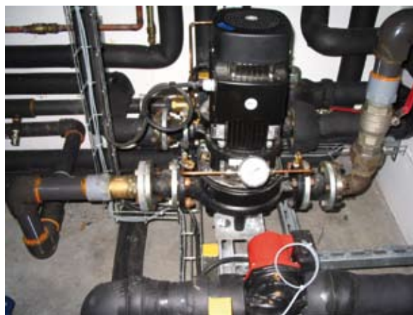
Échangeur thermique Université de Saint-Pierre à la Réunion - Photo MEEDDAT
