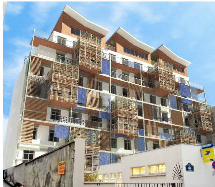
Projet PREBAT/REHA « RE(H)Archi-textures © Pèlerin Architecture
