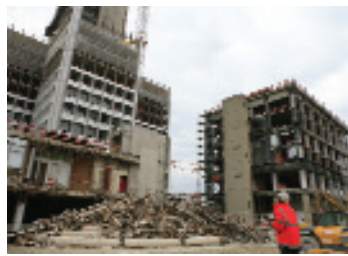
Chantier EDF GDF de démolition-reconstruction à Balard.
