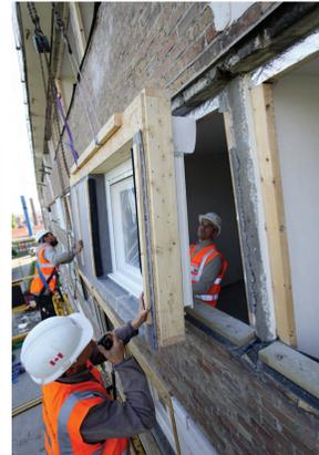
> Pose des façades bois préfabriquées avec menuiseries PVC et volet roulant intégrés (© Jean Drieux)
