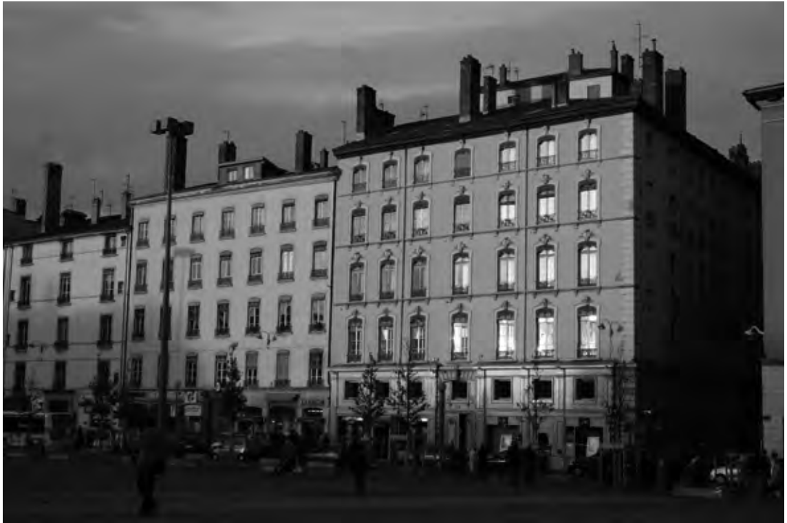
Grands immeubles anciens (type E). (photo F. Robert)
