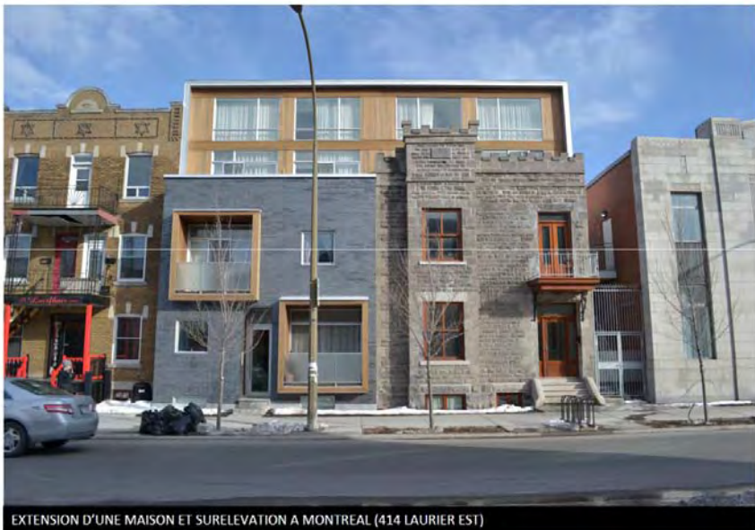
EXTENSION D'UNE MAISON ET SURELEVATION A MONTREAL (414 LAURIER EST)
