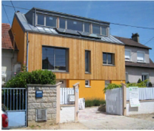
Rénovation énergétique d'un pavillon de 1970 Initiative : 4 co-propriétaires / Maître d'oeuvre : Latitude 48° Localisation : Fontenay-sous-Bois (94)
