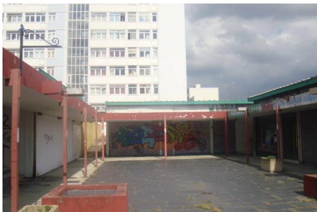
Centre commercial Sarraill avant démolition
