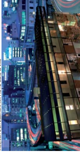
Insertion d'un bâtiment IMPACTE dans la ville
