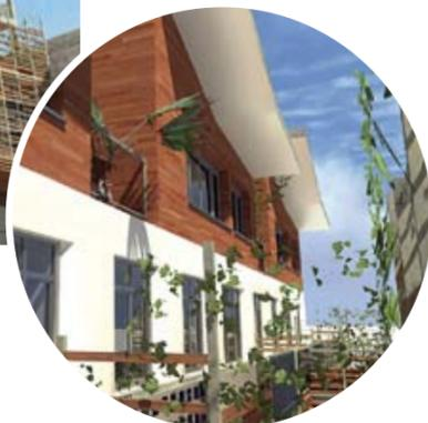
Accessibilité, extension des logements, fermeture des loggias, mais aussi forte isolation des murs sont les points forts d'un projet respectueux de l'architecture d'origine
