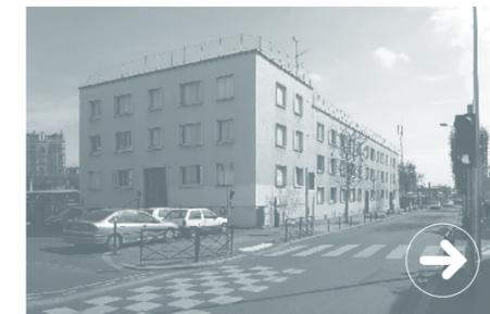
L'intégration dans les plugs de fonctions techniques renforce l'intérêt d'un système qui fait appel à des panneaux préfabriqués autoportants de grandes dimensions
