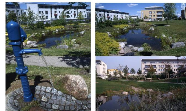
Ce quartier met en valeur ses espaces verts grâce à la présence de l'eau. Les eaux de ruissellement sont acheminées en contrebas vers une rivière par une succession de mini barrages installés dans la pente du secteur urbanisé. Toujours H. Dreiseitl.
