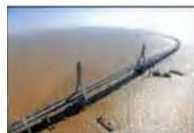
Nouvelle pont Autoroutier de Donghai «32.5Km Au dessous de la mer
