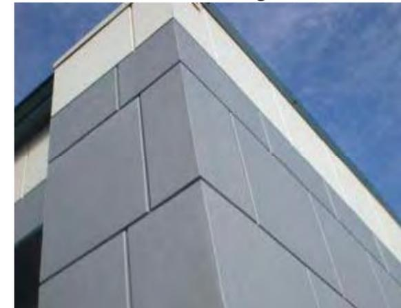
Il s'agit des techniques simplifiées des bardages où l'isolant est associé à un revêtement en usine pour être posé en une seule opération.
