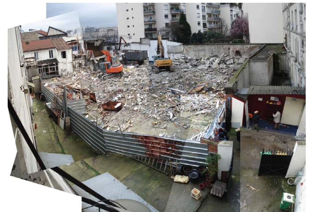
Démolition de l'entrepôt "Penteco" et du Jardin ECObox
