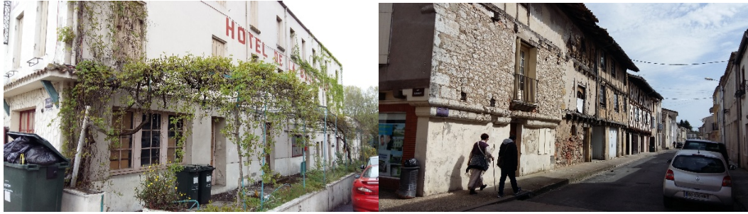
Hôtel fermé place Jean Jaurès et Habitat dégradé Rue des frères Reclus
