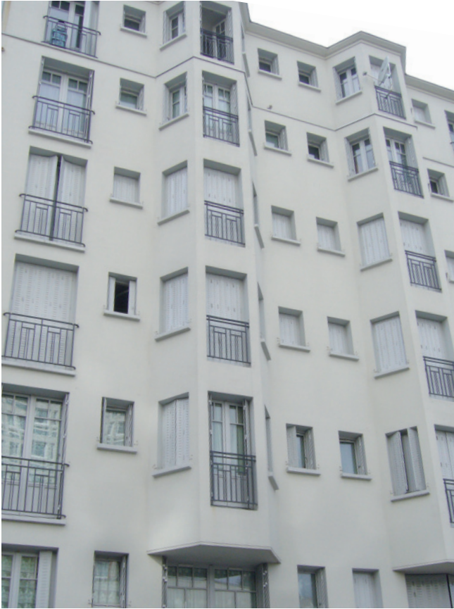
Immeuble de logement collectif, 1931, G. Tissoire architecte, rue Compans, 19 e arrondissement. Façade en brique enduite, ici une isolation par l'extérieure peut être mise en œuvre étant donné l'absence d'ornementation.
