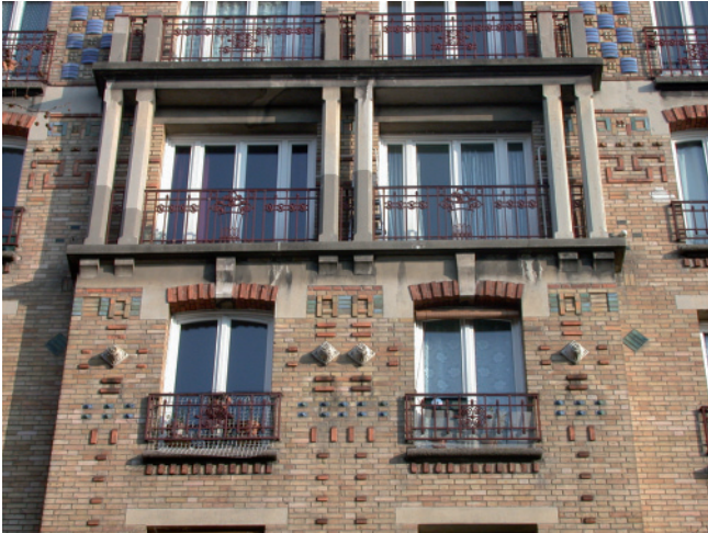
Immeuble de type HBM, 1922-1926, J. Charlet et F. Perrin architectes, boulevard de l'Hôpital, 13 e arrondissement. Le niveau d'ornementation ne permet pas d'entreprendre une isolation extérieure.
