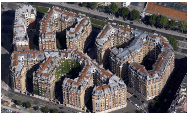
Immeuble de logement type I.L.M., 1924-1926, boulevard Jourdan, 14 e arrondissement.
