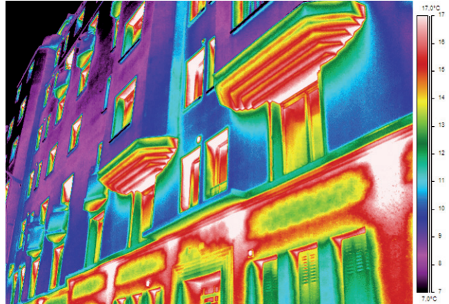
Rue des Carrières d'Amérique, 19 e arrondissement. Fuites thermiques constatées sous les oriels.
