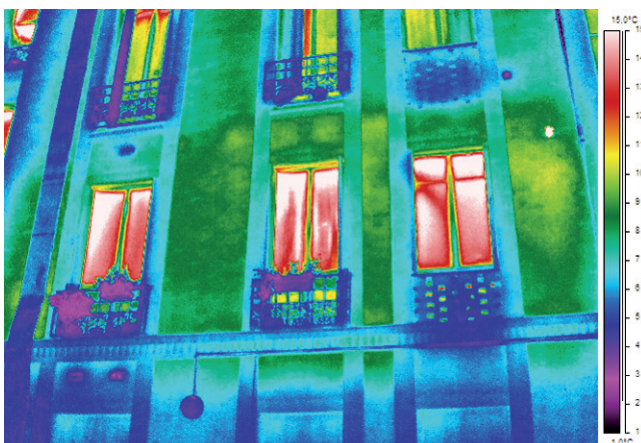
Boulevard Barbès, 18 e arrondissement. Trou de ventilation à droite de l'image.
