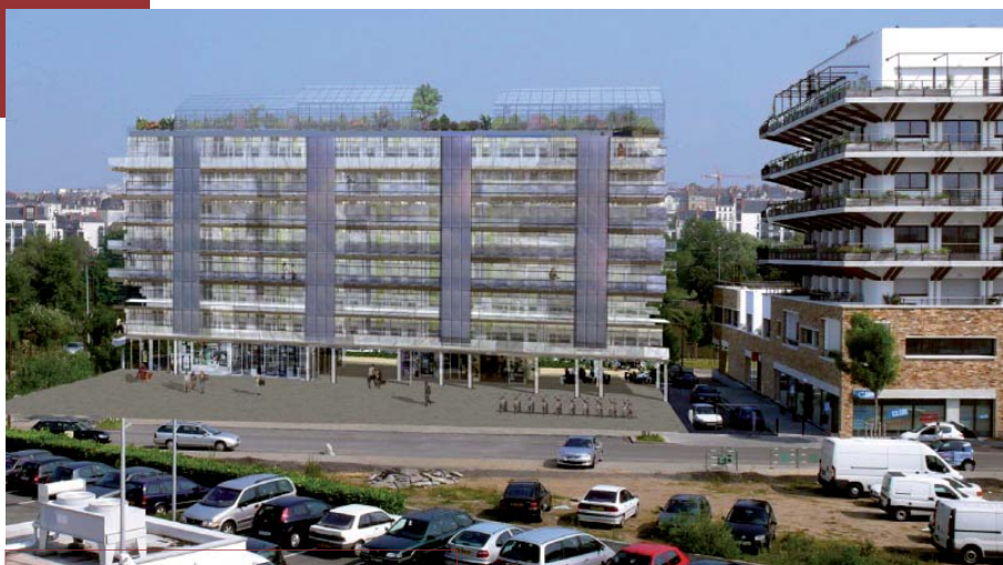
La façade nord de ce projet revisite le principe selon lequel cette façade doit être plus isolée (Altersmith).
