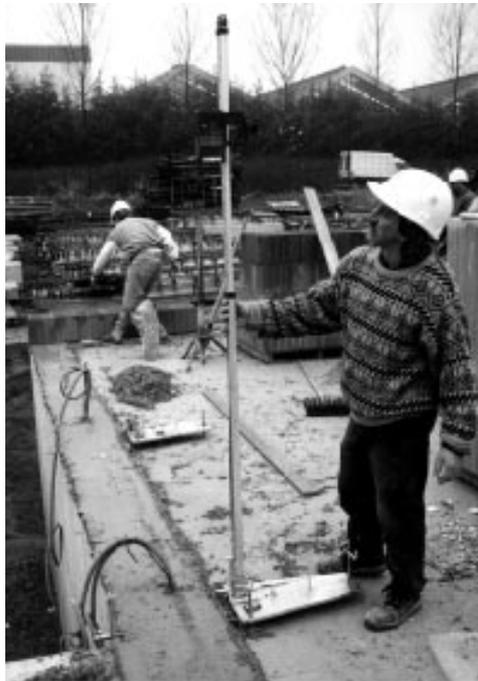
été utilisé. Il est composé de deux platines dont la hauteur est réglée à l'aide d'un laser. Ces platines servant ensuite de support à une règle qui permet d'obtenir une arase parfaitement de niveau.
