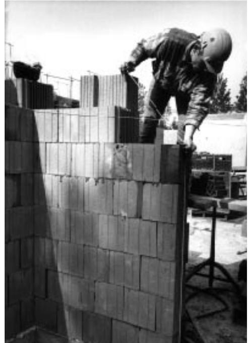
la gamme des blocs, pour une réalisation plus aisée des points singuliers, serait par ailleurs nécessaire. Autre point : une formulation de mortier-colle, correspondant à une plage de température plus large, reste à définir. Dernier point : à Reims, la pose au rouleau a conduit à des temps de mise en oeuvre compris entre 35 et 45 min/m<sup>2</sup> avec une consommation de colle de l'ordre de 3,3 kg/m<sup>2</sup>.
