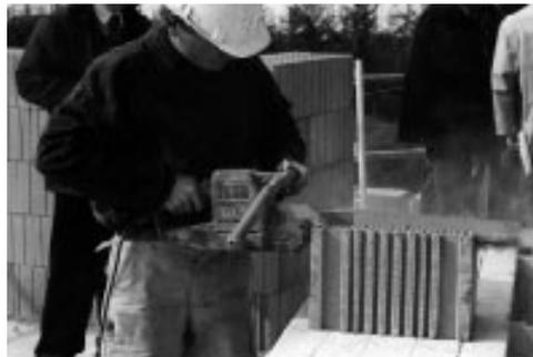
ce point de vue, d'aboutir à un excellent résultat. Sur ce chantier, les murs ont été montés sans plan de calepinage en raison de la facilité de découpe des produits en terre cuite. Cependant, malgré la porosité des tessons de terre cuite, l'usure des lames de scie reste importante (1 lame pour 500 m<sup>2</sup> environ).
