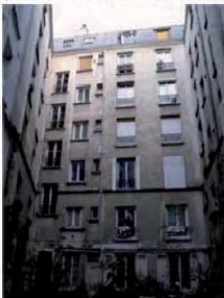
Cour côté 11 rue de Panama
