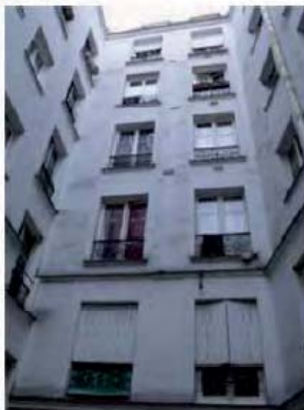
Cour côté 9 rue de Panama
