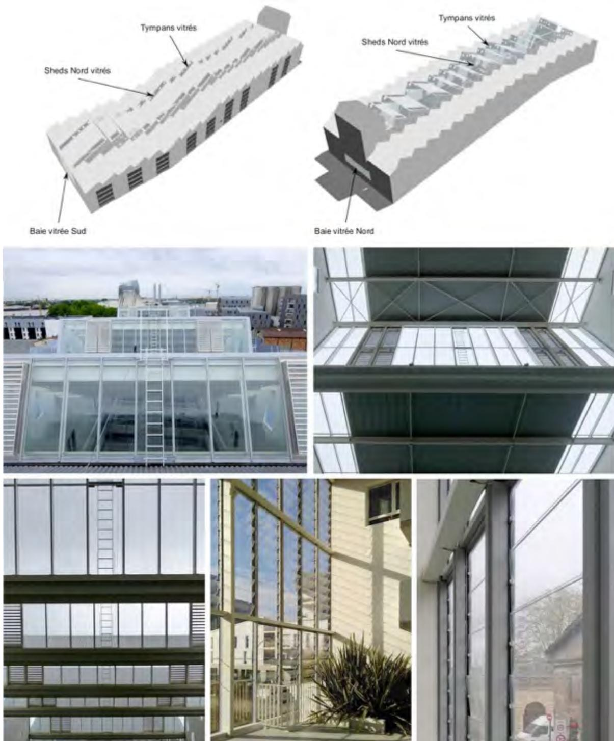
*III. 27 Les organes de l'atrium bioclimatique. Principe des sheds orientés et exutoires de ventilation. Vantelles d'amenée d'air des halls d'entrée et de l'atrium.*
