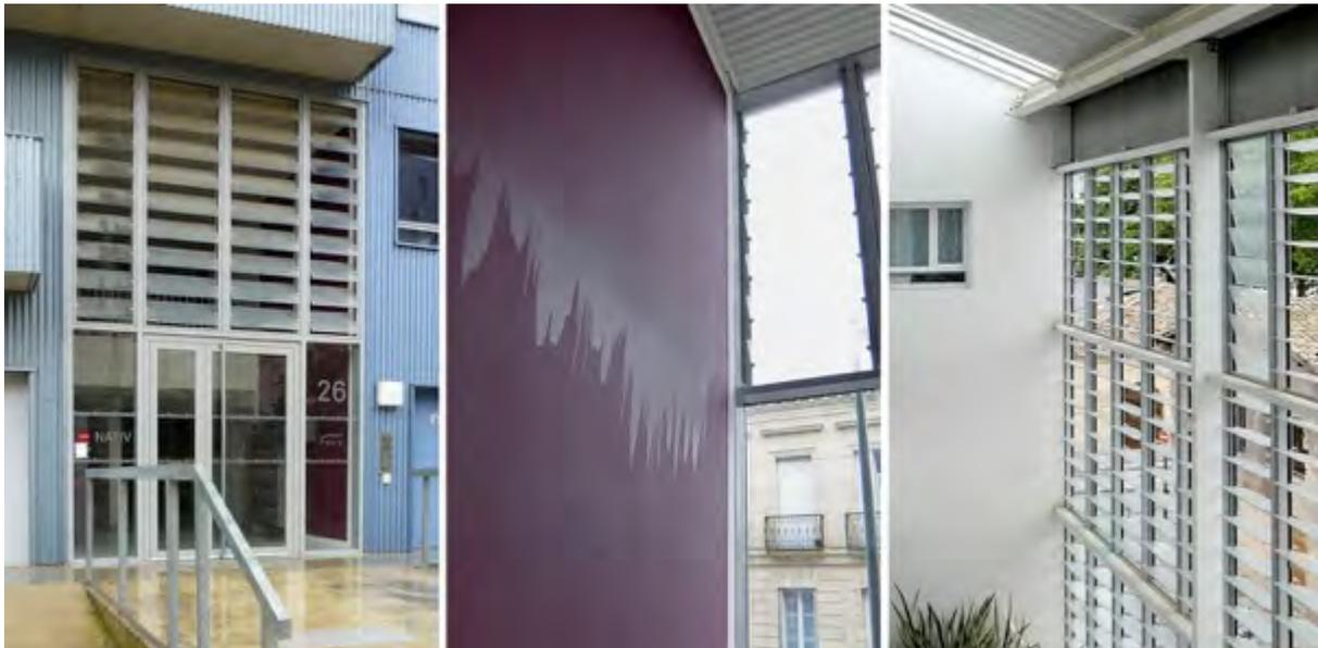
**III. 29 Constats de dysfonctionnement des vantelles : ouverture lors d'un orage, décoordination des panneaux.**
