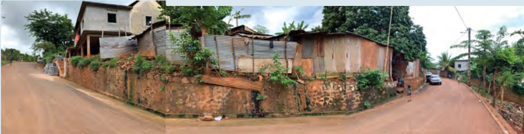
Vue sur la rue Mwandzani
