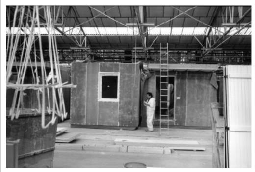
en blocs béton, délimitant le volume du vide sanitaire. Hormis pour ces travaux, le chantier présente une activité considérablement réduite par rapport aux techniques constructives traditionnelles. Les travaux de soubassement en maçonnerie sont complétés par les travaux de VRD, la charpente, la couverture, l'aménagement des combles (cas des T4) et les finitions aux raccords entre modules.
