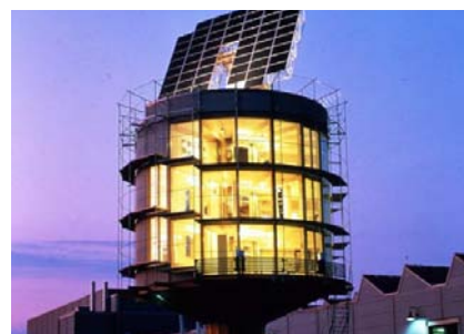
Héliotrope , maison solaire, Rolf Disch, 1994.
