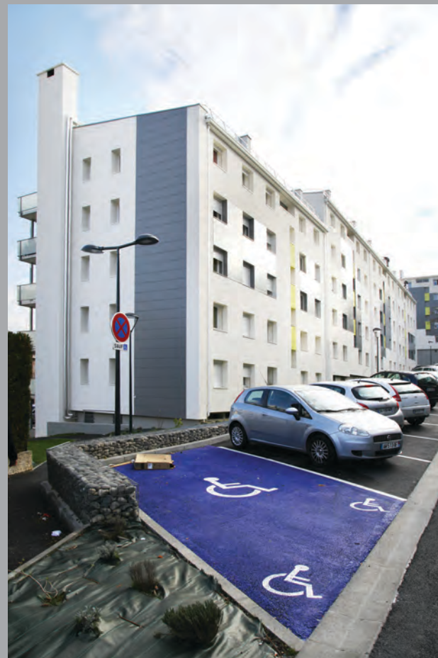
Façade ouest du bât. A vue depuis la rue de la Nive (au fond le bât. B)
