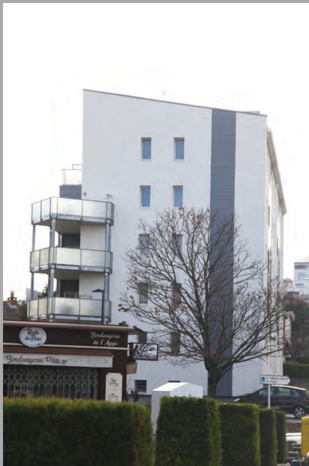
Pignon du bât. E vue depuis la rue de l'Ayga
