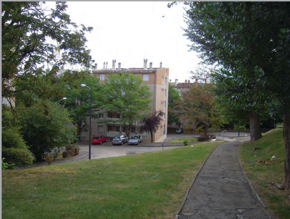
Vue sur le bât. G depuis le cœur d'îlot (au fond le bât. A)
