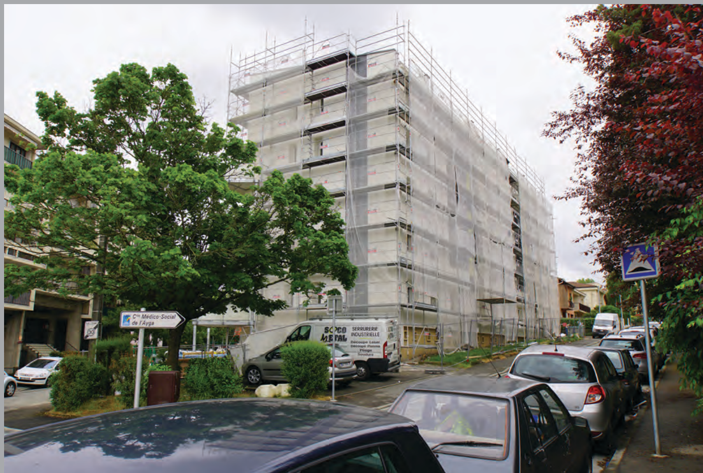
Traitement de la façade ouest du bât. E sur la rue de l'Ayga
