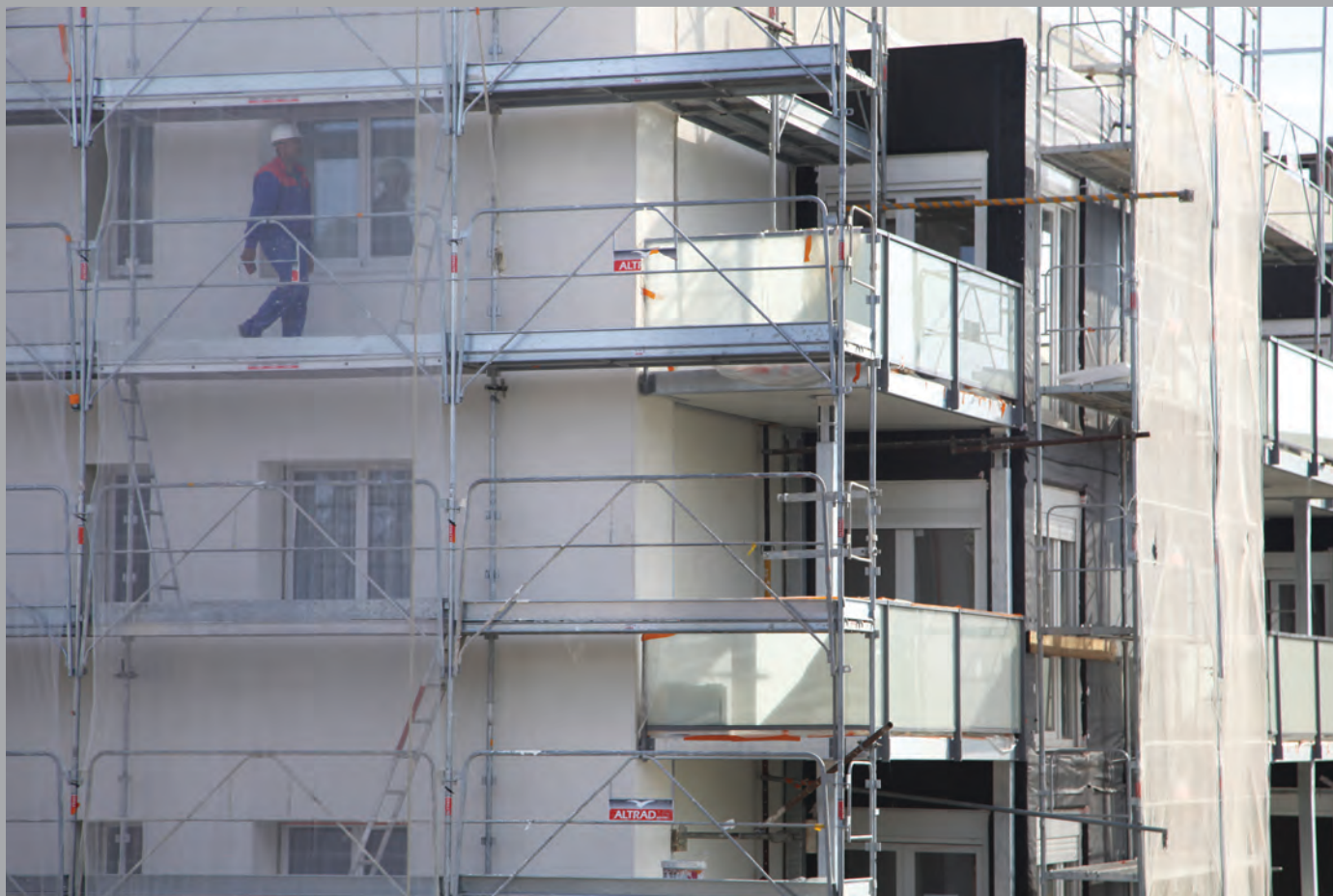
Détail sur les extensions créées et le traitement des pignons
