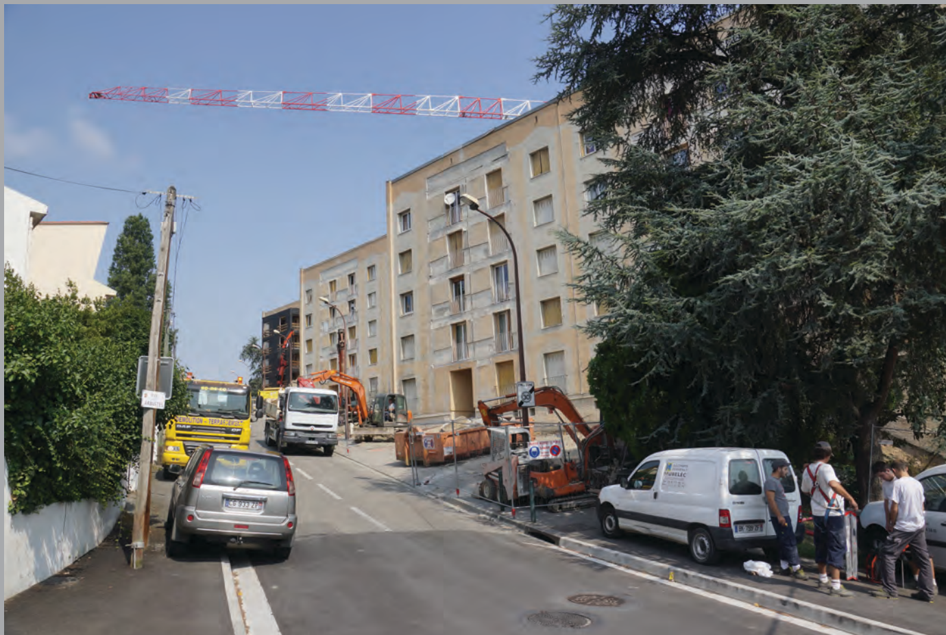
Sciage des balcons des bât. B, C vue depuis le bas de la rue des Arbustes
