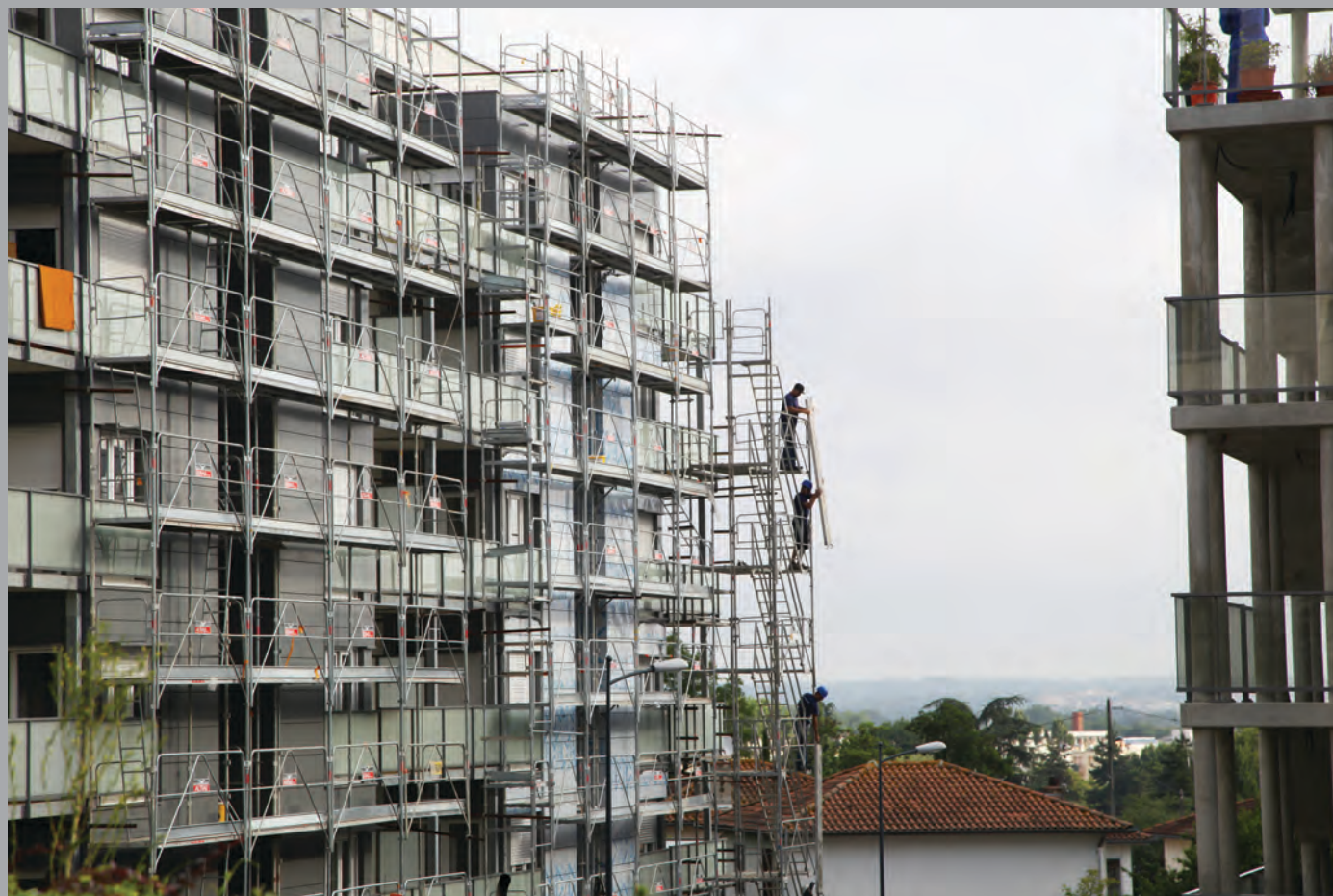
Réalisation des extensions en façade est du bât. E
