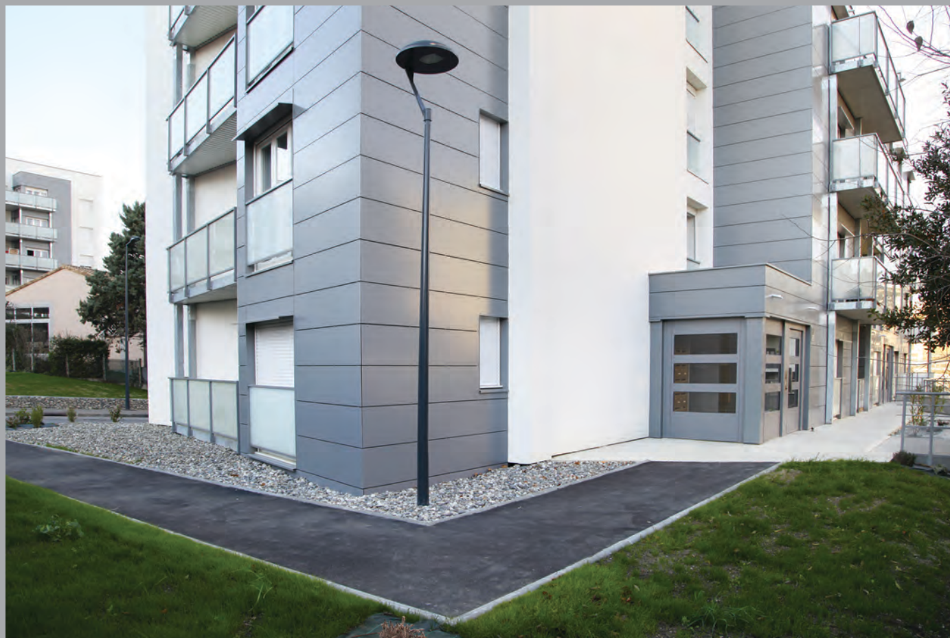
Mise en accessibilité et traitement du pied d'immeuble du bât. E
