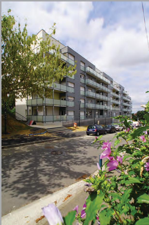
Façade est du bât. G vue depuis le haut de la rue de l'Ayga
