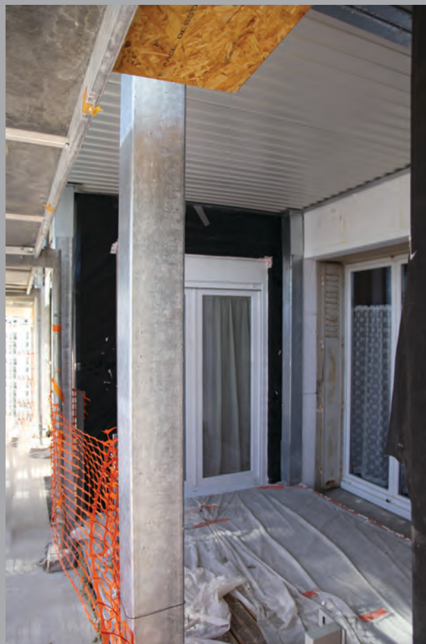
Vue depuis une terrasse créée sur l'agrandissement d'un appartement
