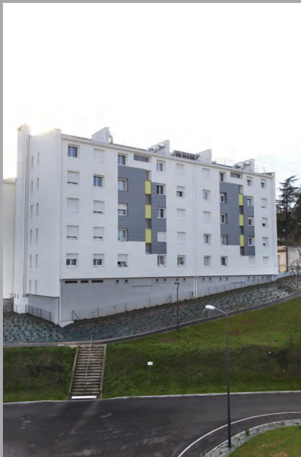
Façade nord du bât. D vue depuis le cœur d'îlot
