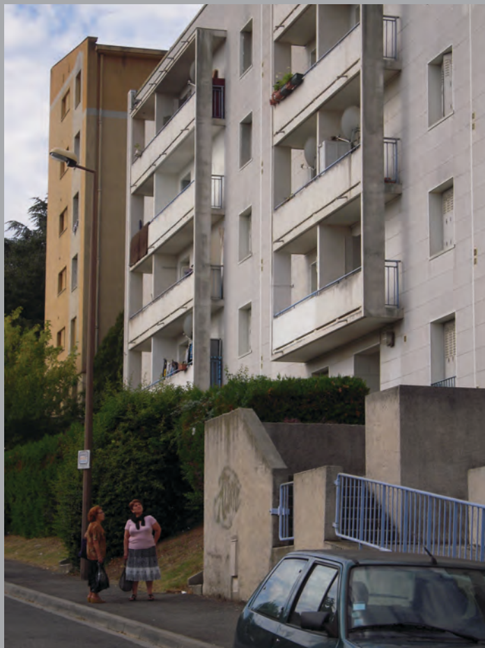
Détail sur loggias du bât. A rue de l'Ayga
