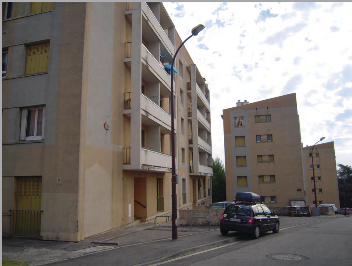
Bât. B,C,D vue depuis le haut de la rue des Arbustes
