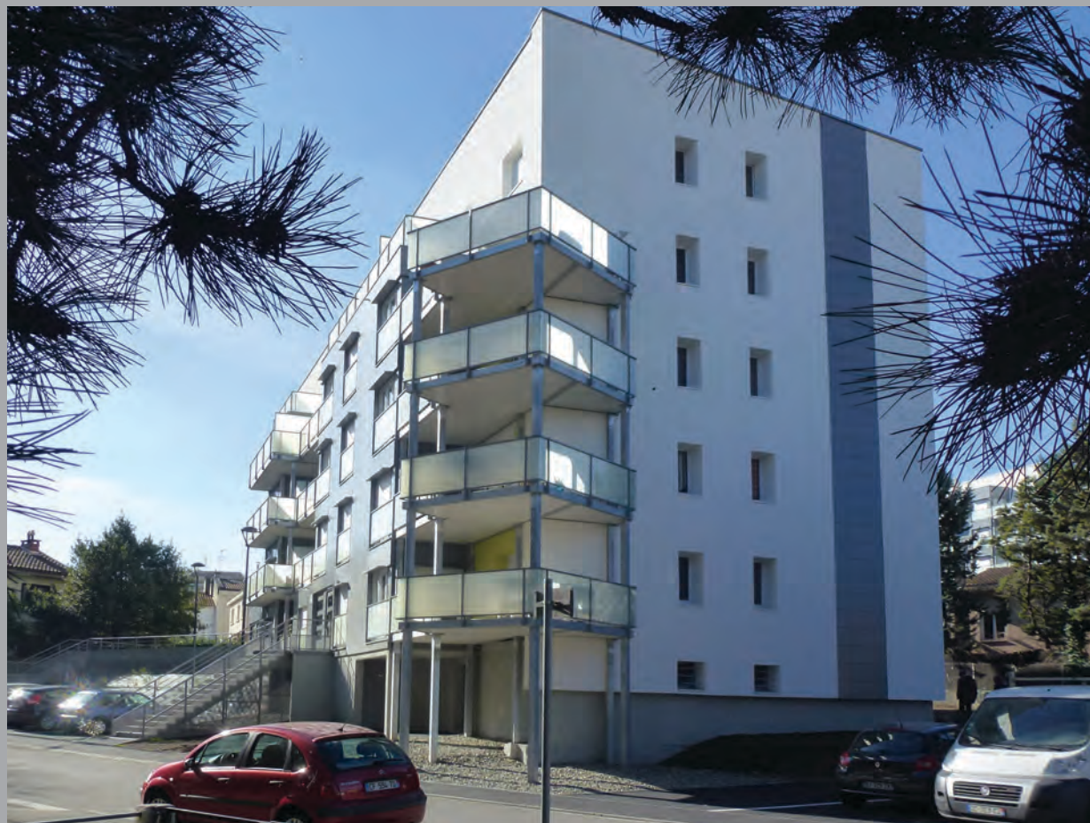
Pignon et extensions du bât. E sur la rue des Antilles
