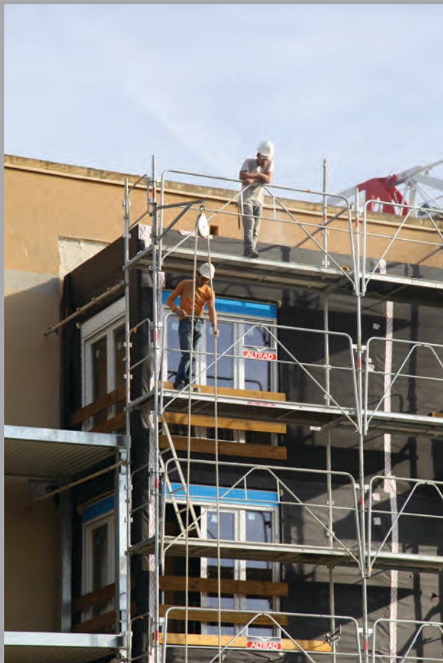
Pose des garde-corps vitrés du bât. D
