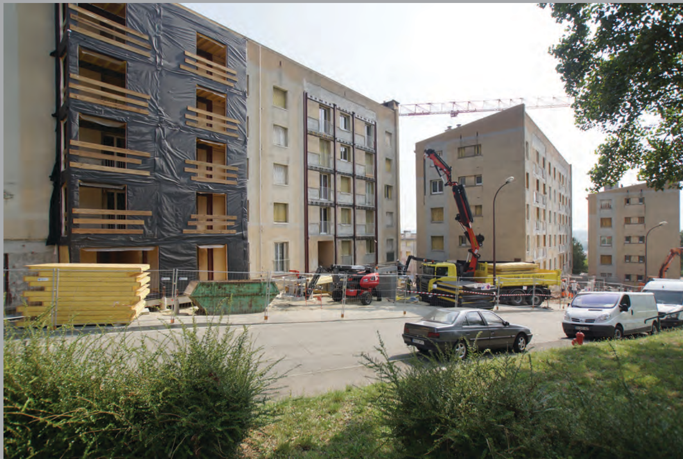
Réalisation des extensions préfabriquées pour l'agrandissement des séjours du bât. D
