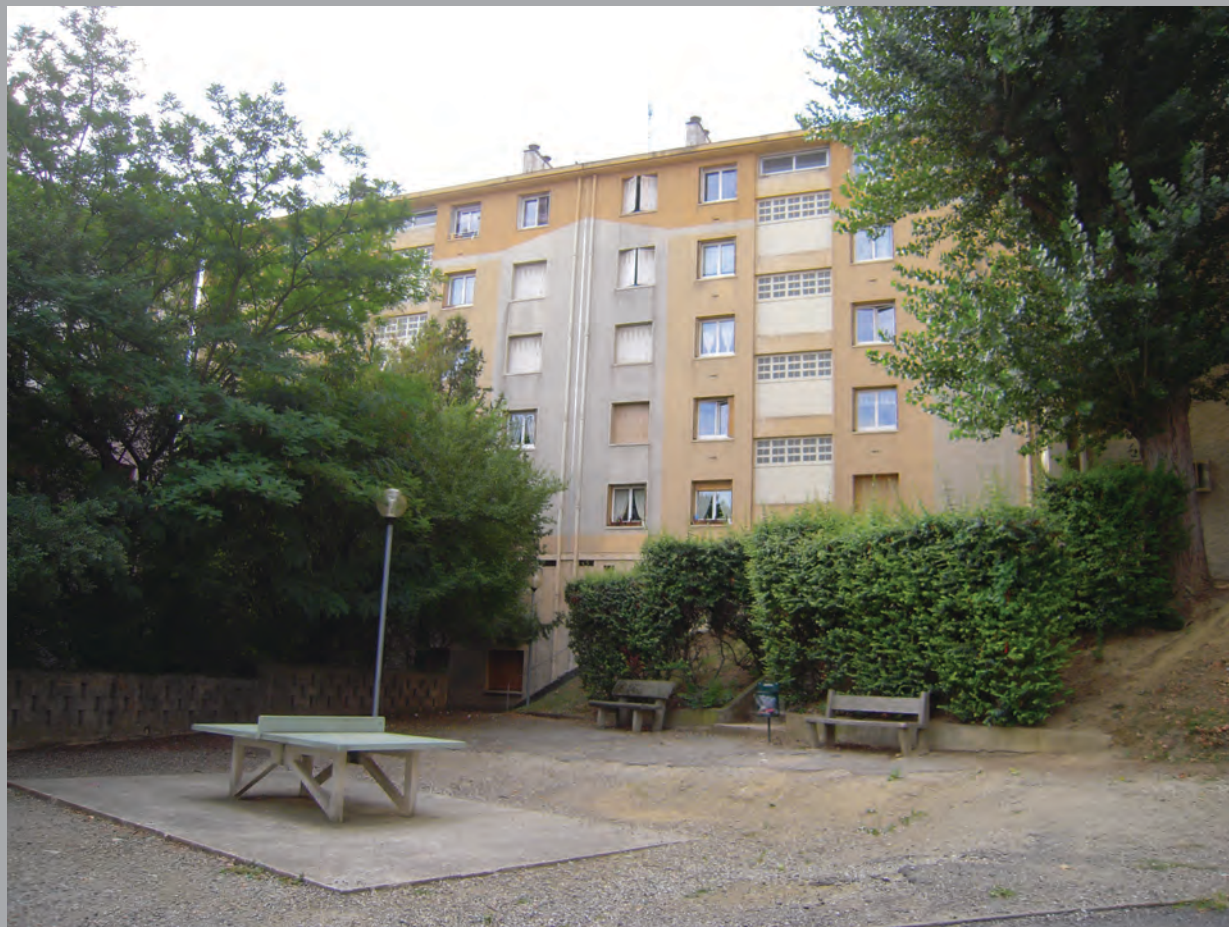
Façade nord du bât. B vue depuis le cœur d'îlot
