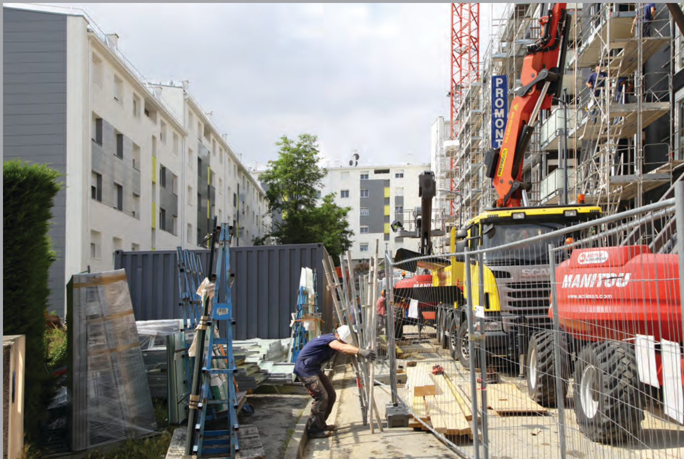
Vue depuis la rue de la Nive (à gauche le bât. A requalifié, à droite réalisation des extensions en façade est du bât. G)
