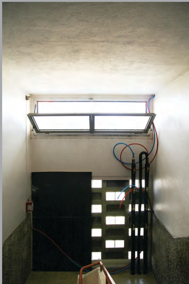
Cage d'escaliers avant/après requalification
