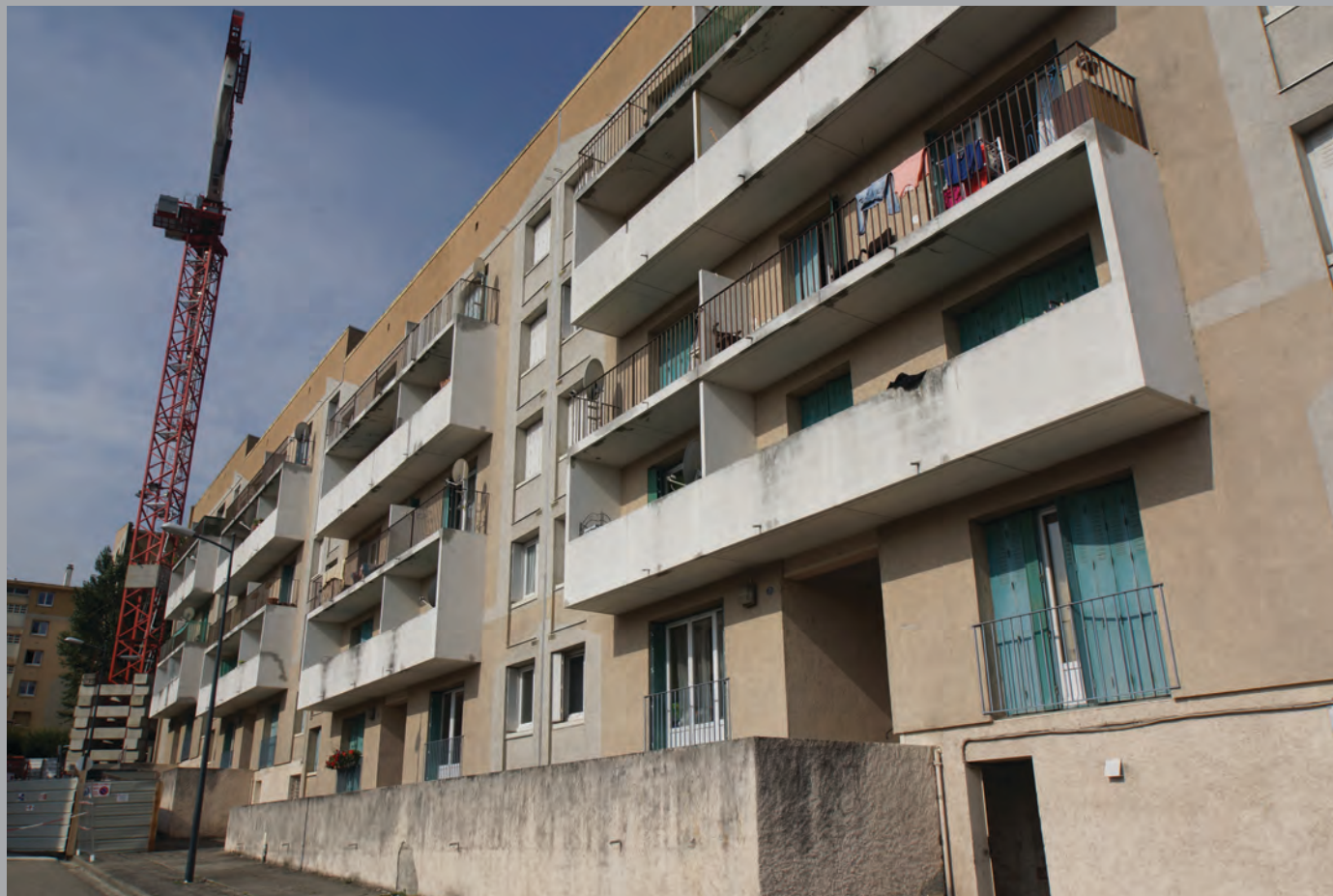
Détail sur loggias du bât. G vue depuis le bas de la rue de la Nive
