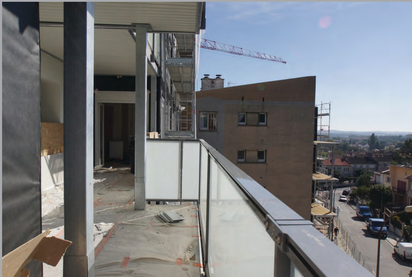
Vue sur une loggia créée
