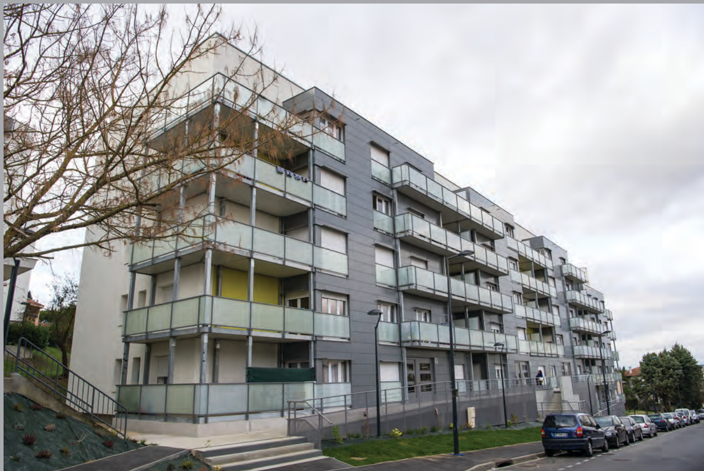
Façade est du bât. A vue depuis le haut de la rue de l'Ayga
