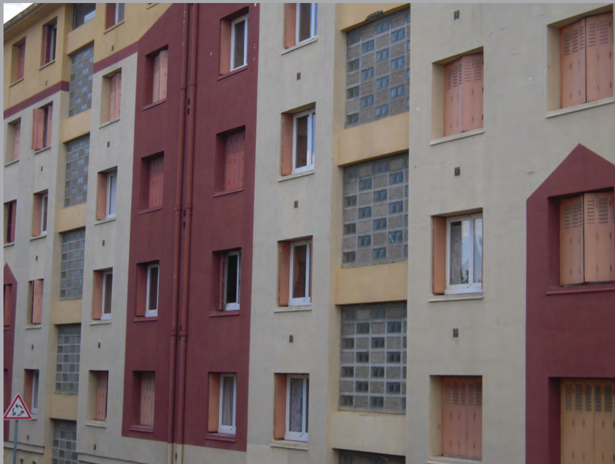
Détail de la façade ouest du bât. E rue de l'Ayga
