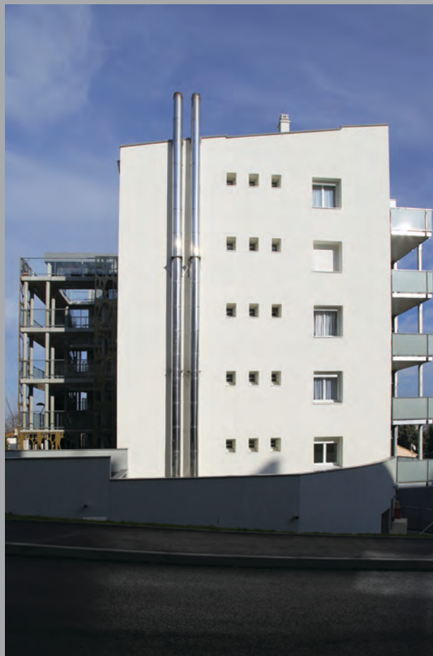
Pignon du bât. G vue sur la chaufferie biomasse
