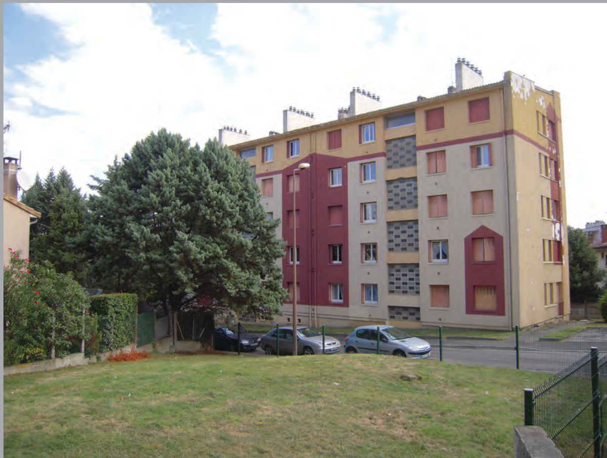
Bât. E vue depuis la rue de la Nive
