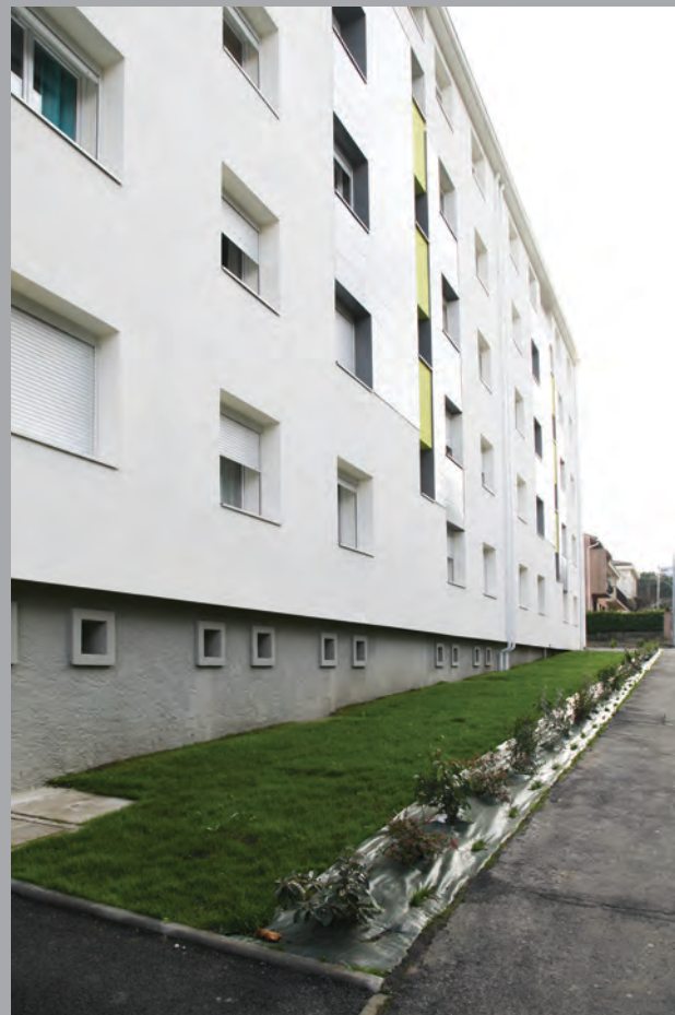
Façade du bât. E sur rue de l'Ayga
