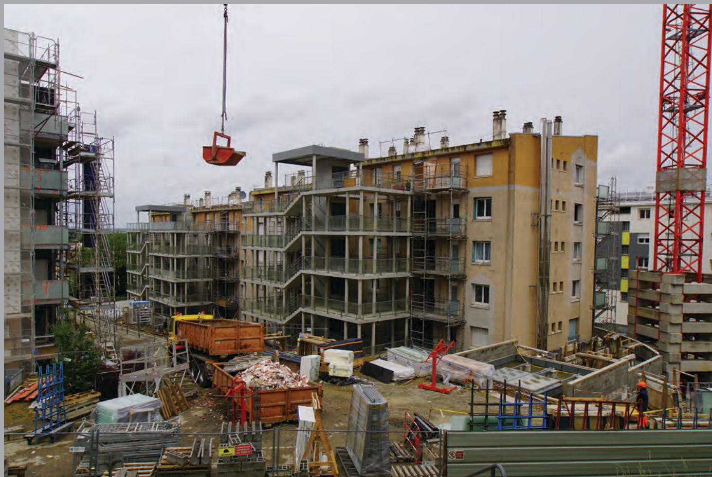
Réalisation des coursives, escaliers et cages d'ascenseurs du bât. G
