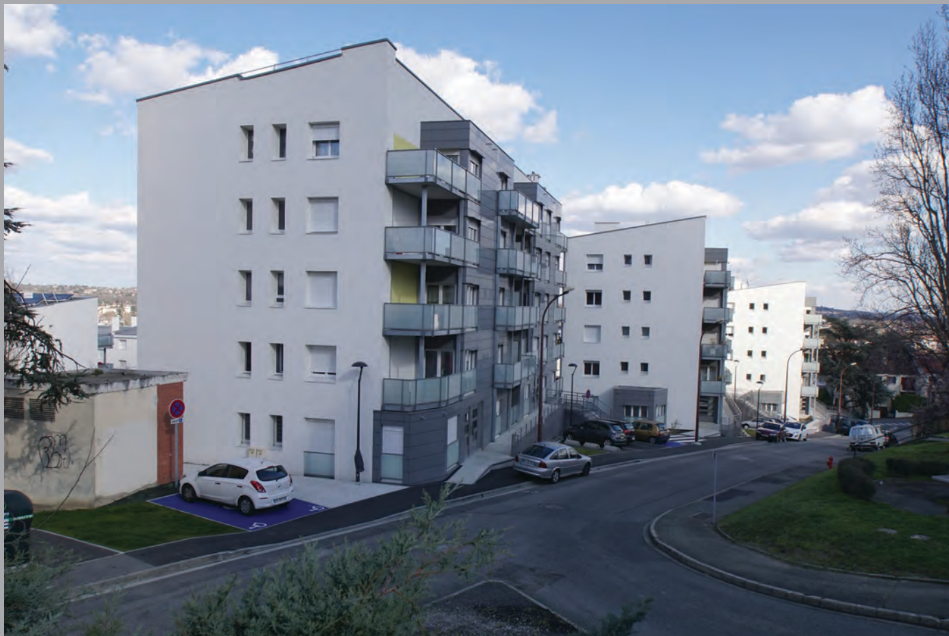
Bât. B,C,D vue depuis le haut de la rue des Arbustes
