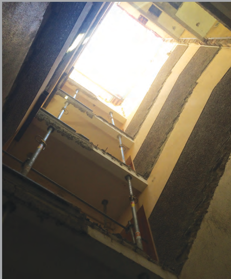
Sciage des demies-volées d'escaliers existantes et évacuation par la grue
