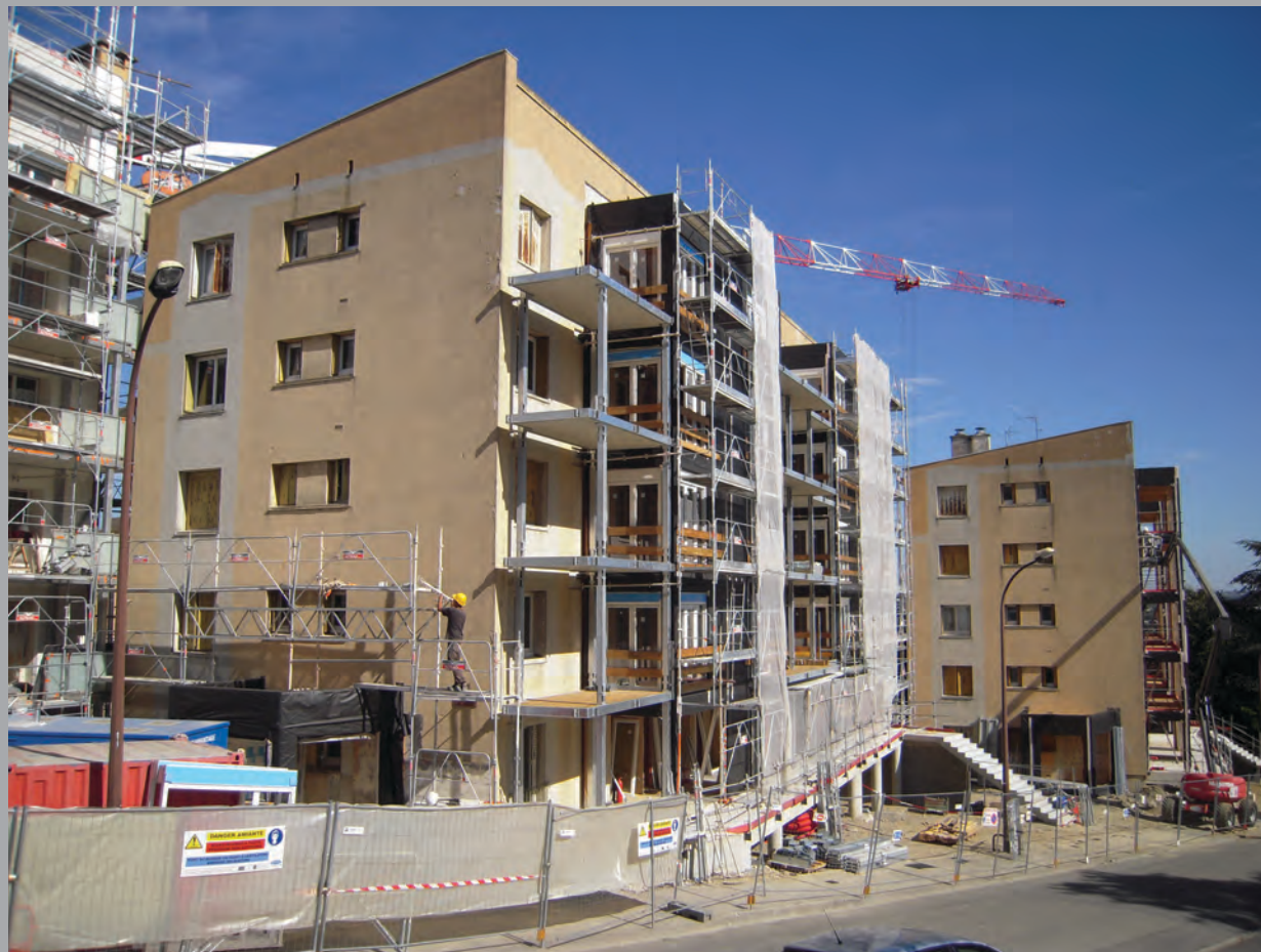
Pose des éléments de terrasses des bat. C, D
