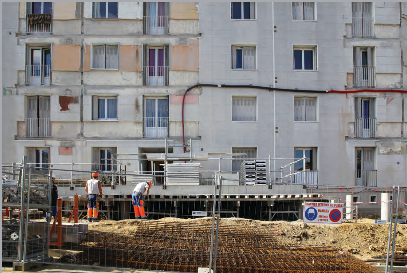
Détail sur l'installation du chantier en site occupé
