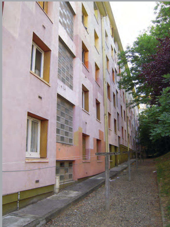
Façade ouest du bât. A vue depuis le cœur d'îlot
