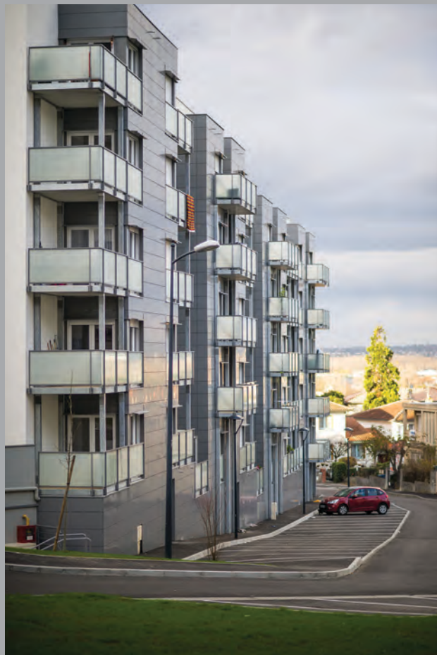
Façade est du bât. G sur rue de la Nive
