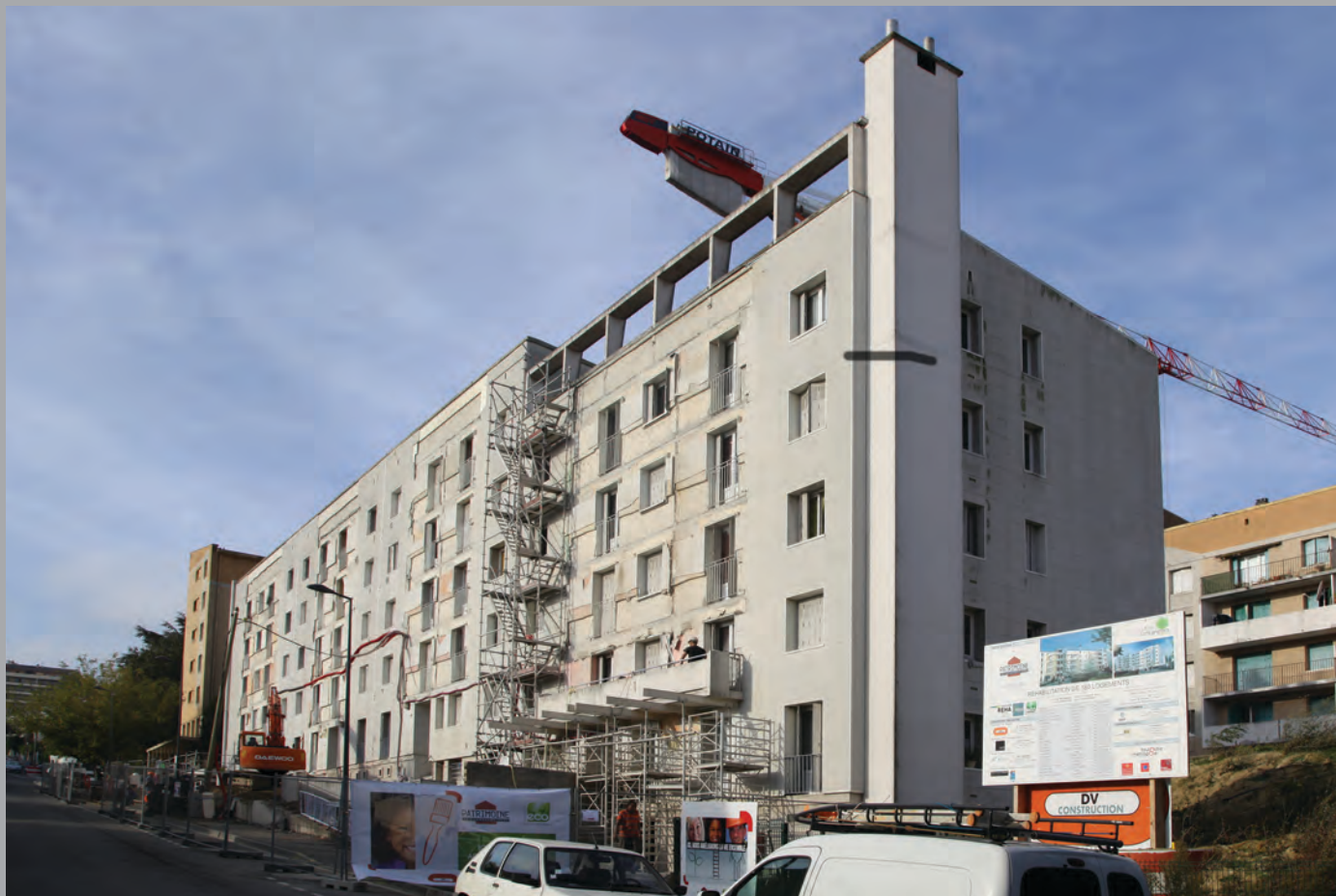
Sciage des balcons du bât. A vue depuis le bas de la rue de l'Ayga
