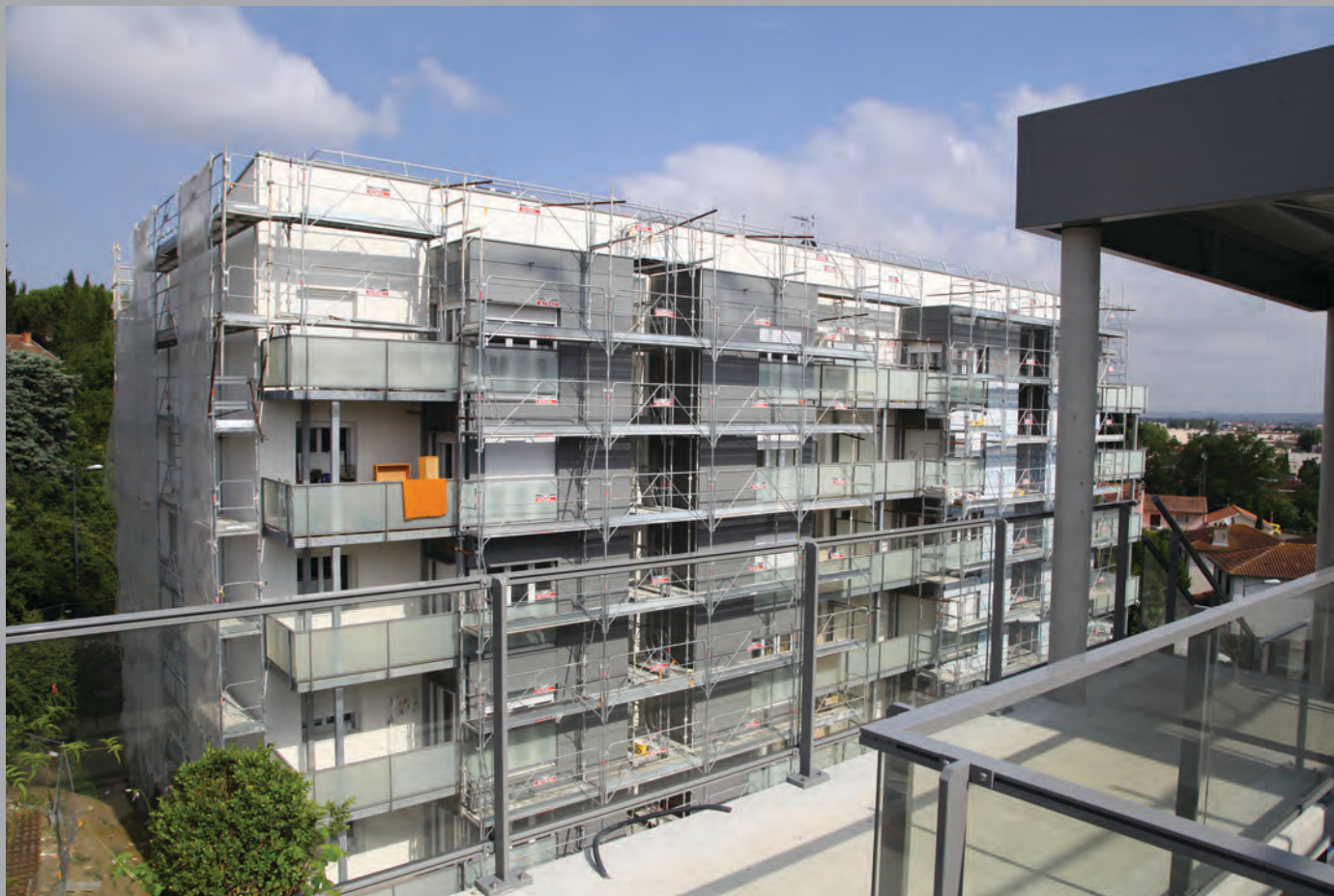
Façade est du bât. F vue depuis les coursives du bât. G
