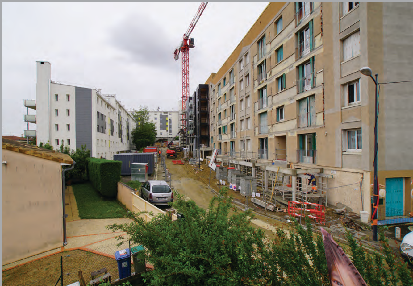
Sciage des loggias en façade est du bât. G vue depuis le bas de la rue de la Nive
