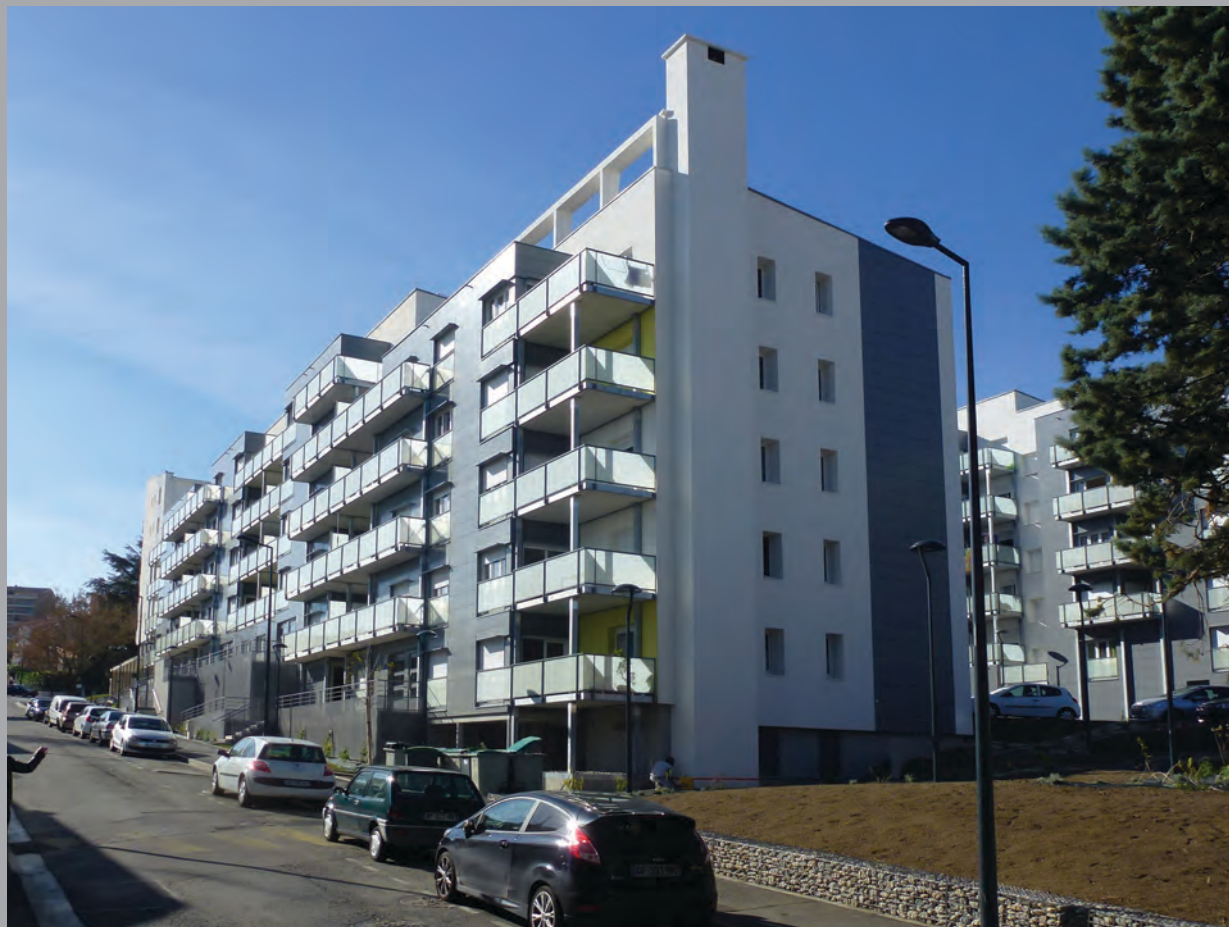
Façade est du bât. A vue depuis le bas de la rue de l'Ayga (à droite le bât. G)
