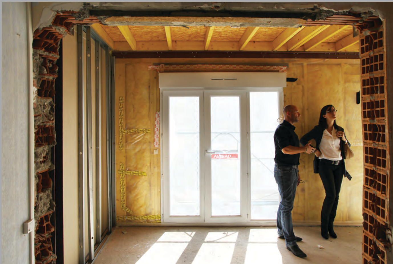
Détail sur l'ouverture créée dans le mur porteur de la façade existante
