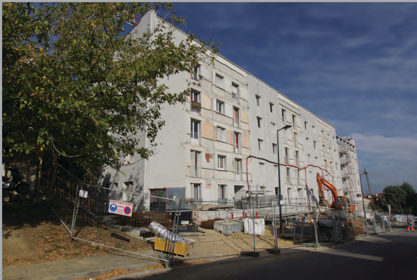
Sciage des balcons du bât. A vue depuis le haut de la rue de l'Ayga
