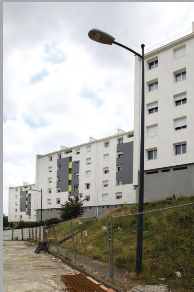
Façades des bâtiments B,C,D vue depuis le cœur d'îlot
