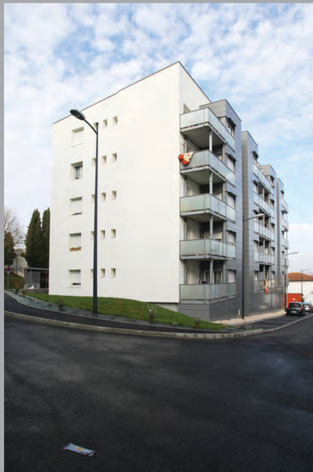
Pignon et façade ouest du bât. F
