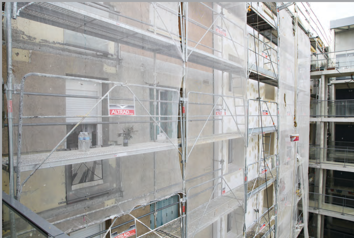
Détail sur le traitement de façade
