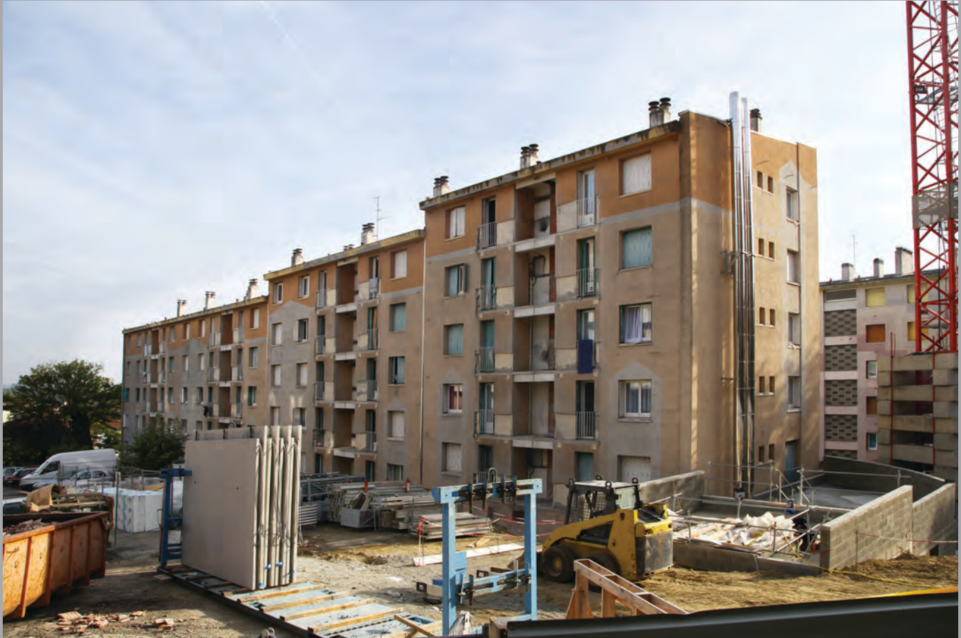
Dépose des garde-corps opaques de la façade ouest du bât. G
