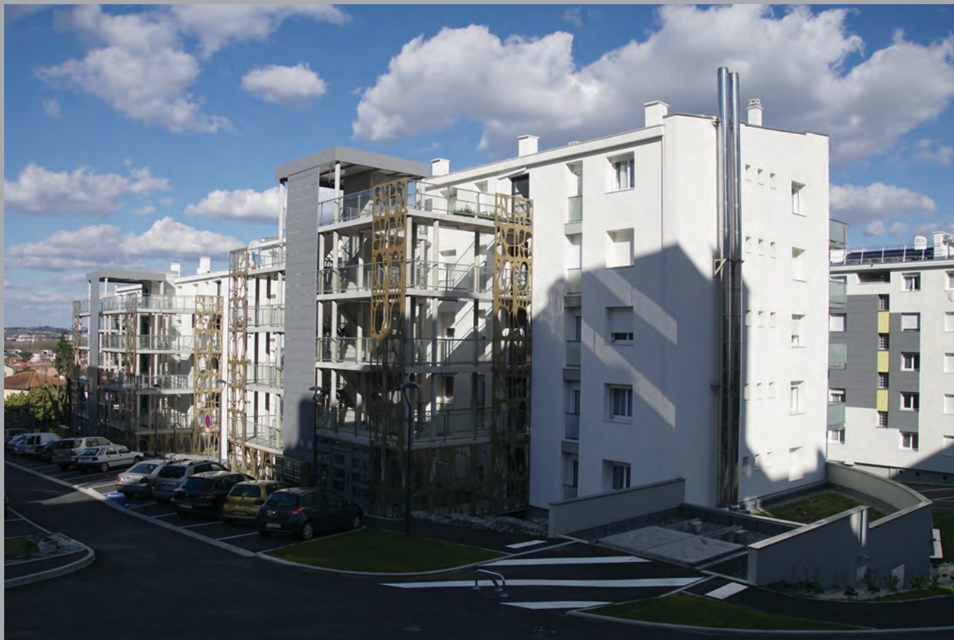
Façade ouest du bât. G vue sur les distributions et stationnements
