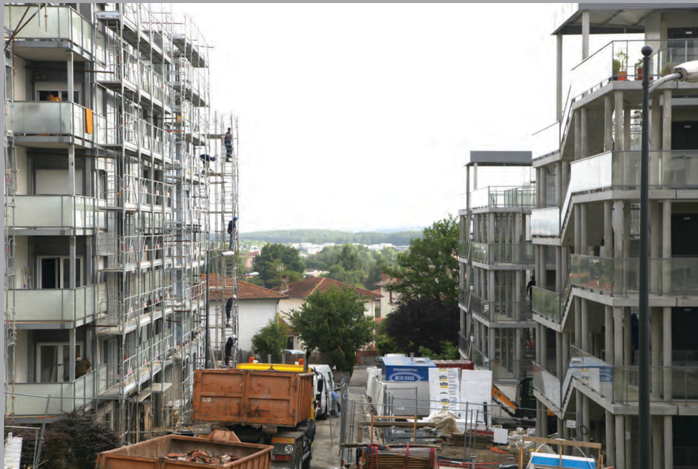
A gauche le bât. F, à droite réalisation des distributions en façade ouest du bât. G
