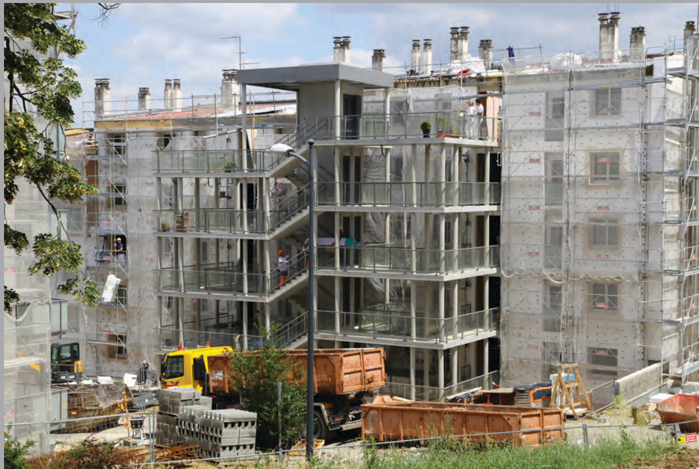
Pose des garde-corps en verre et traitement de la façade ouest du bât. G
