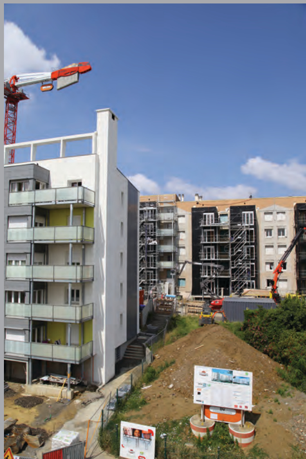
Vue du bât. G en travaux depuis la rue de l'Ayga
