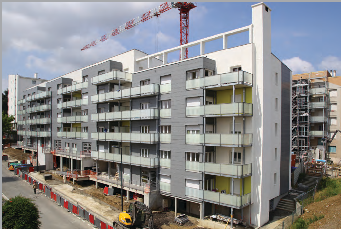
Travaux des RDC et des accès du bât. A
