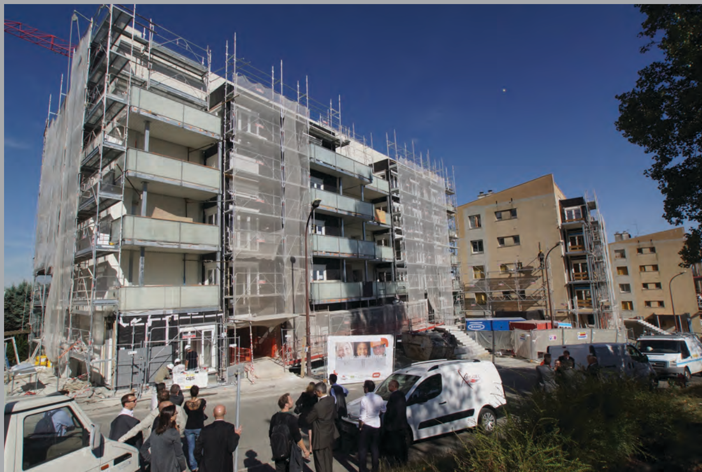
Extensions en façade sud des bât. B,C,D vue depuis le haut de la rue des Arbustes
