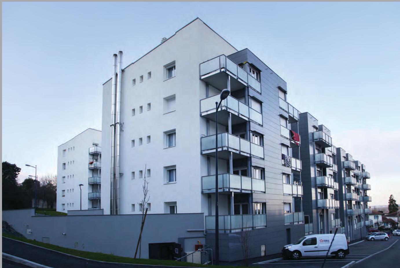
Façade est du bât. G sur rue de la Nive
