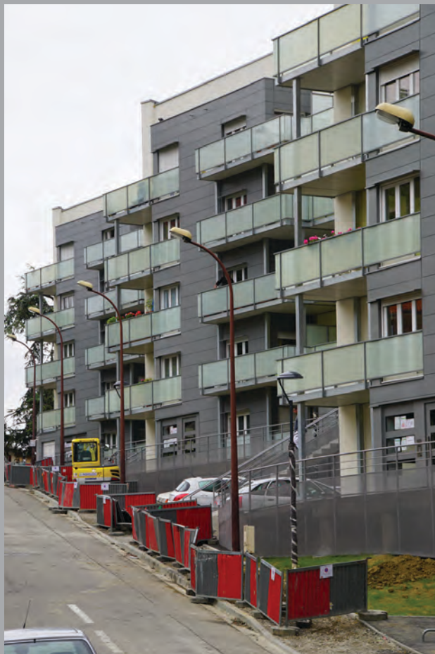
Façades des bât. B,C,D vue depuis le bas de la rue des Arbustes
