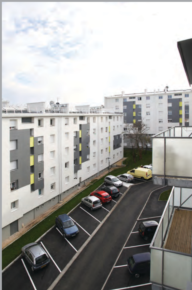
Vue depuis le bât. G sur la bât A (à gauche) et le bât. B (au fond)
