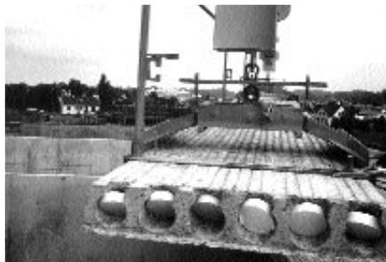
Les dalles retenues sont des dalles BONNA, selon l'Avis Technique CSTB 3/91-226, disposant d'une certification CACES 329-87.226. Elles sont fabriquées à l'usine BONNA, titulaire d'une certification AFAQ ISO 9002. Le béton des dalles est mis en place par extrusion, ce qui garantit un béton d'une excellente qualité. Sa résistance caractéristique est certifiée à la valeur de 60 MPa en compression.
