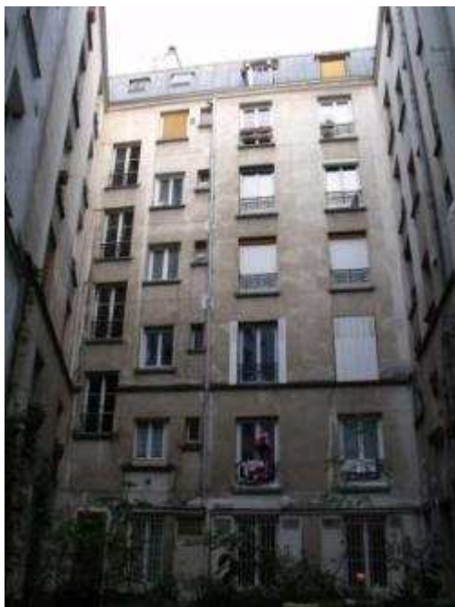
Cour côté 11 rue de Panama
