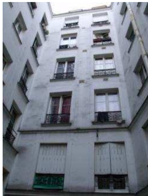
Cour côté 9 rue de Panama
