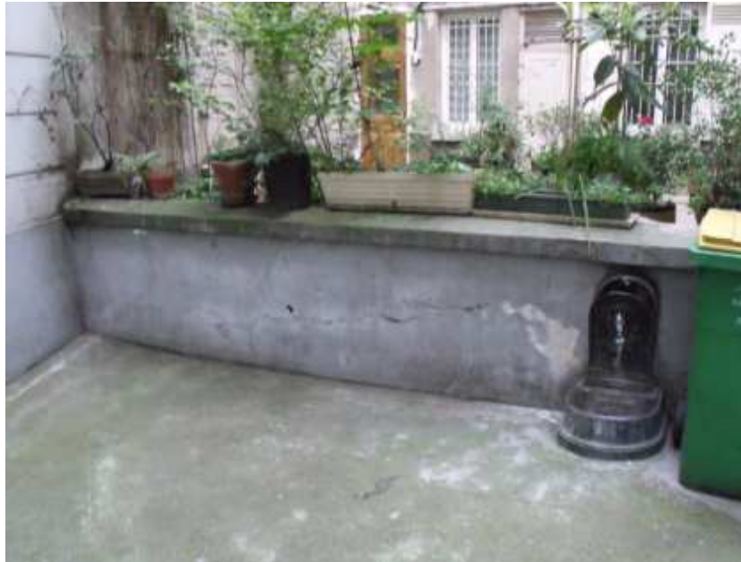
Muret de la cour intérieure 9 et 11 rue de Panama
