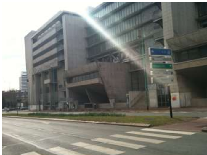
Figure 31 : La façade Est de l'université des chênes, avec son parking en rez-de-chaussée.
