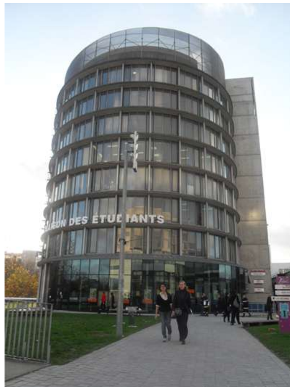
Figure 39: La maison de l'étudiant du site des Chênes
