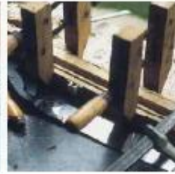
Les joints et les rebords sont à réemployer s'ils sont en bon état et si leur destination est la même que celle des pièces à réemployer.
