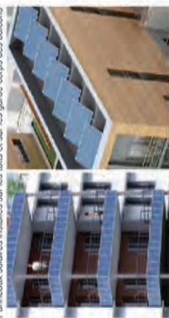
Panneaux solaires installés sur les toits et sur les garde-corps des balcons
