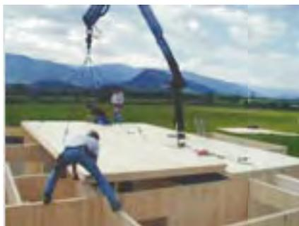
Grâce à la disposition croisée des planches longitudinales et transversales, les variations dimensionnelles sont considérablement réduites, et les performances mécaniques ainsi
