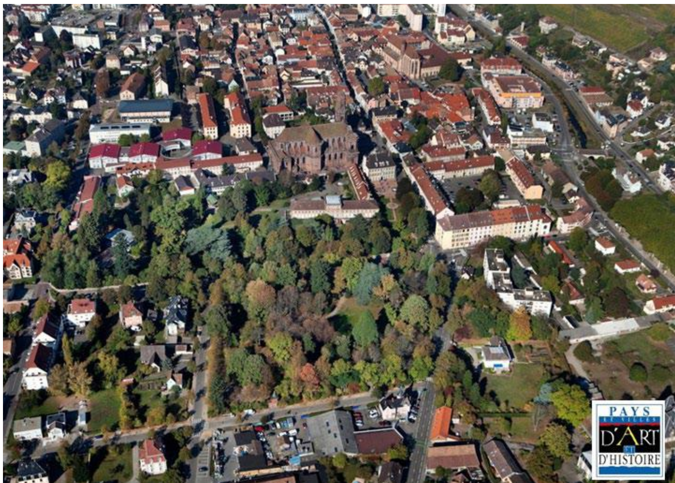
Vue aérienne sur le Parc de la Marseillaise , le château de la Neuenbourg, l'Eglise Notre Dame
