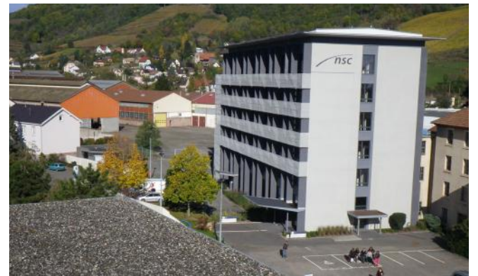
Bâtiment 36, immeuble de bureaux, îlot NSC
