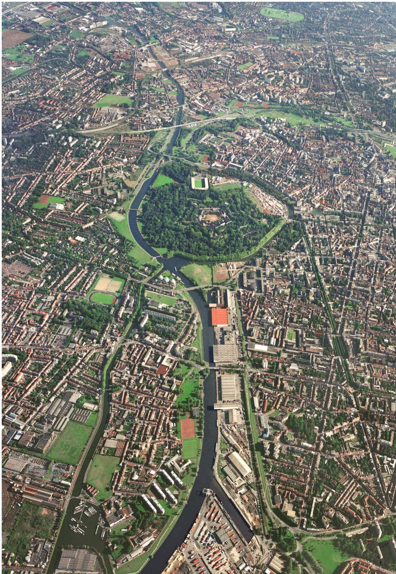
Vue semi-aérienne de la Citadelle et canal de la Deule
