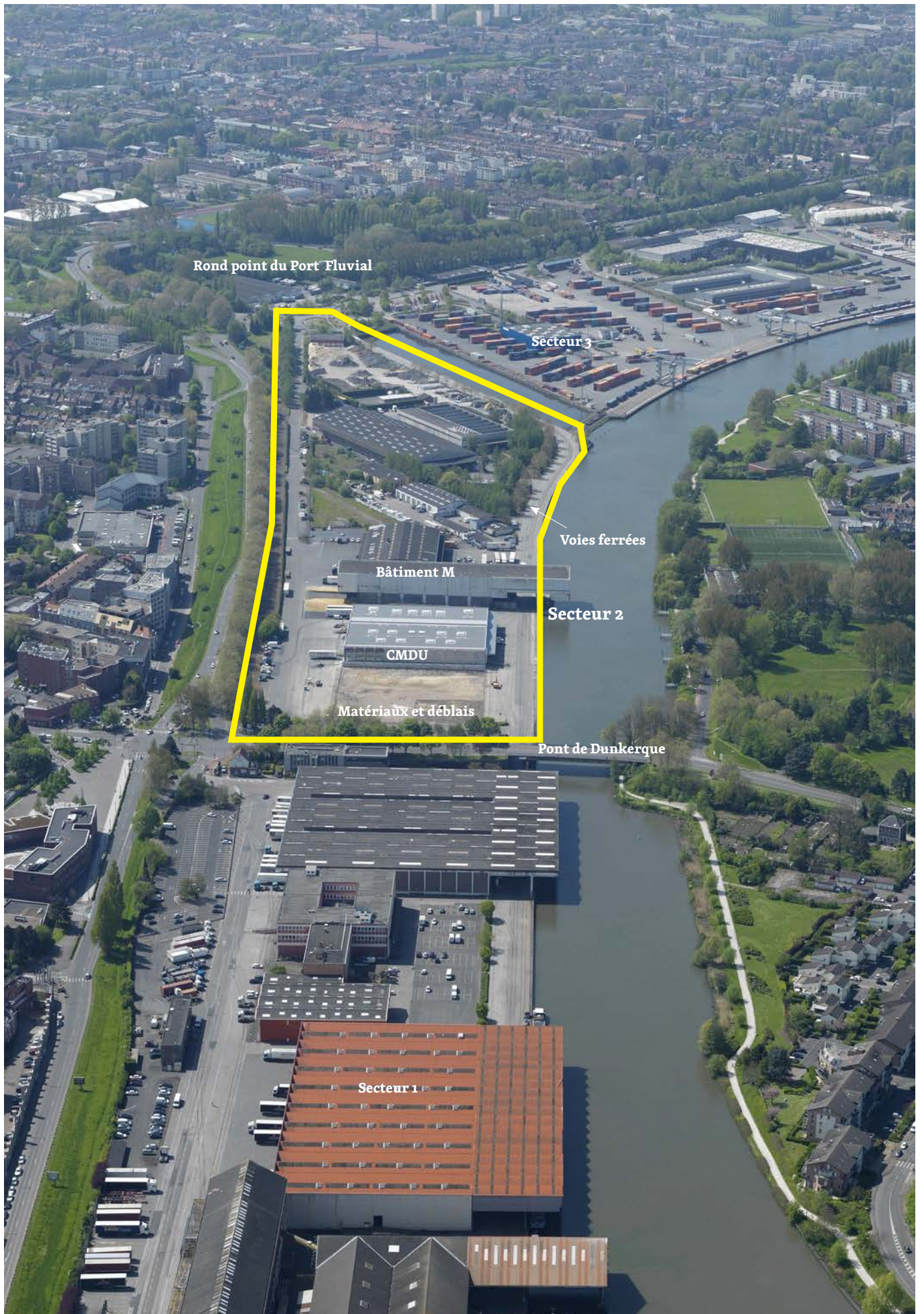
Vue semi-aérienne du site de projet
