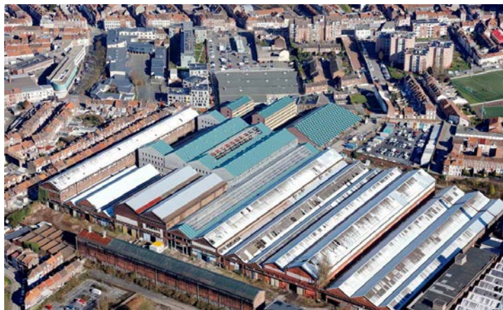
Vue semi-aérienne de lycée hôtelier à Fives Cail Badcock (FCB)
