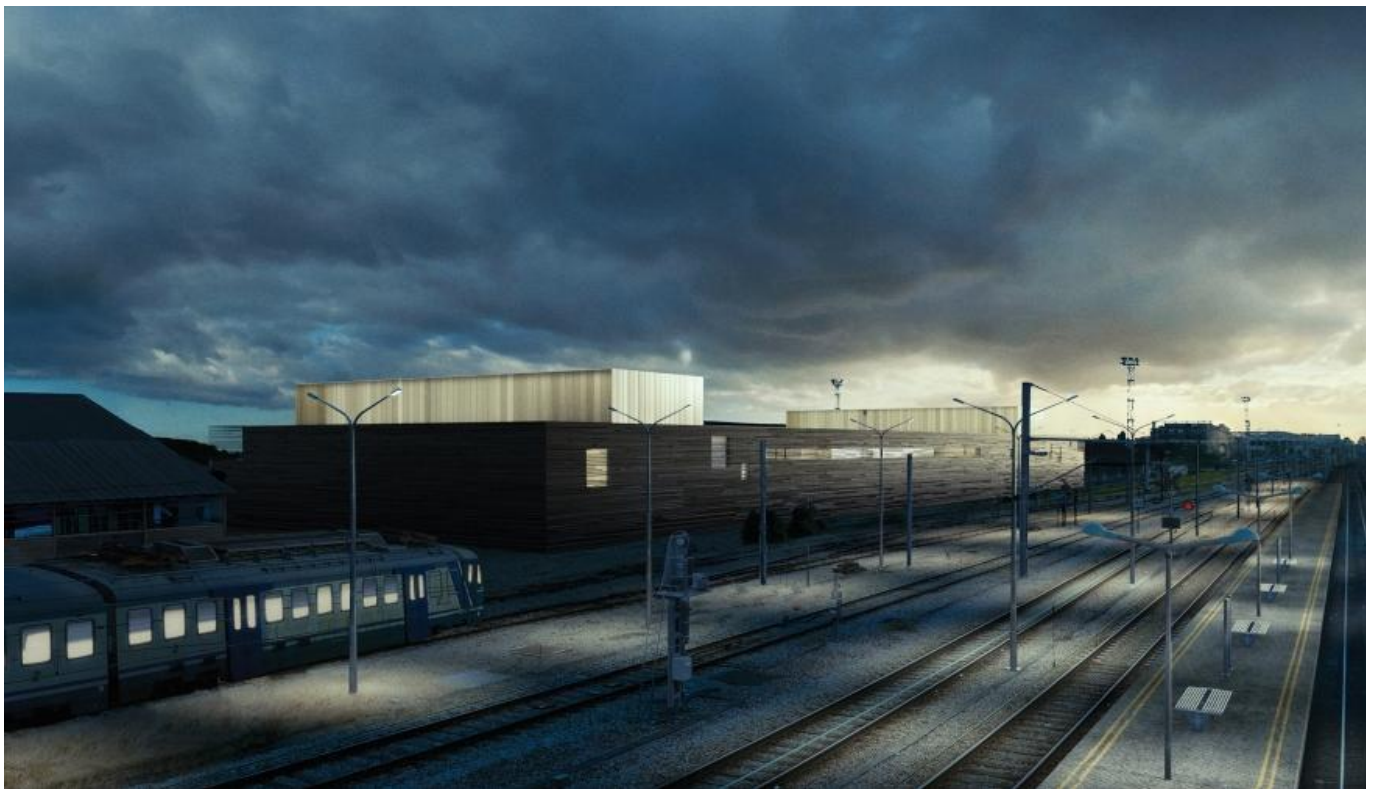
CCU/ CCR - centre de commande unique / commande centralisée du réseau - Railway Signaling Center for the RER E and Paris Est area @ SCAPE
