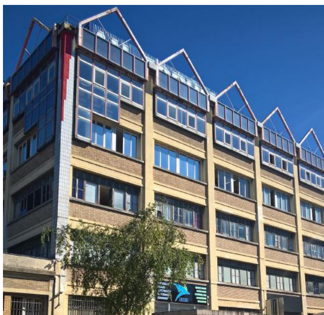
Le Forum du bâtiment, situé rue du Chemin de Fer
