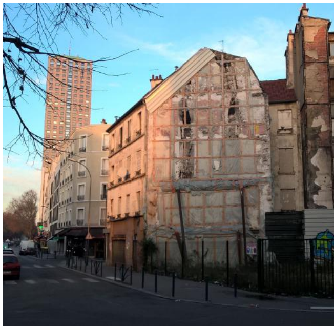
Opération de rénovation urbaine, rue Pasteur.
