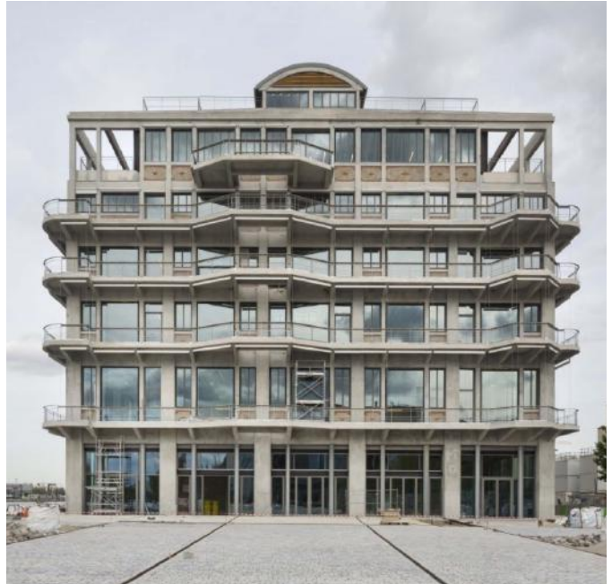
La reconversion en bureaux (agence BETC) des Magasins Généraux
