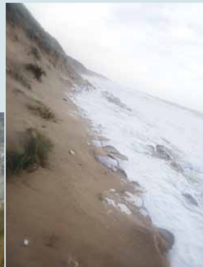
4. Le sable reste derrière les big-bags.
