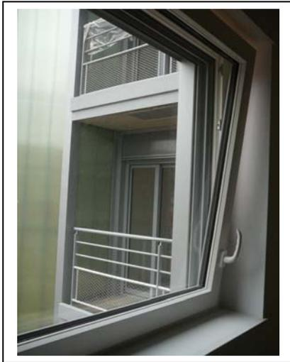
**Figure 5.3 - Coffrage des fenêtres sur les façades isolées par l'extérieur**
