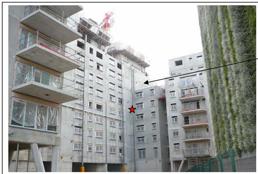
**Figure 8.2.8 – B3g. Les murs aveugles entre partie accession et logements sociaux sur une même parcelle (flèche). La façade aveugle végétalisée des bureaux au Sud, à droite de la photo, pour respecter les prospects.**
