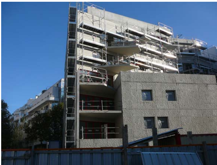
Figure 4.3 – Les tests de couleurs et de prototypes (chantier, septembre 2011)- Photos GERU
